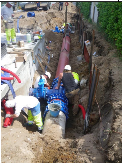
Raccordement de la station de pompage au collecteur nord
