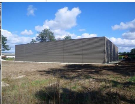
Enveloppe du bassin de sécurité
