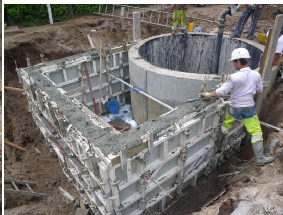
Coulage de la chambre à vannes
