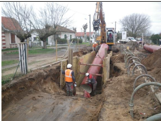
Pose d'une canalisation en fonte ø 800 mm
