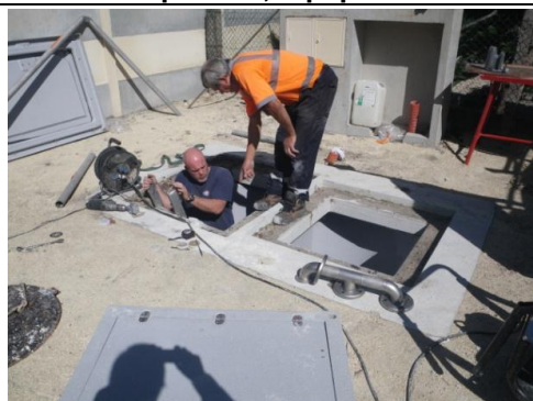
Détails de la bache de pompage et des équipements (en cours de montage)
