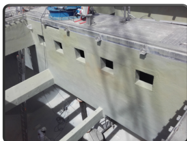
Rénovation du décanteur lamellaire de la tranche 1
