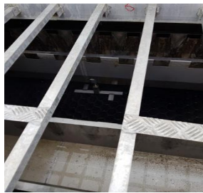
Ci-dessous: exemple de la mise en œuvre du supportage pour maintenir les blocs lamellaires
