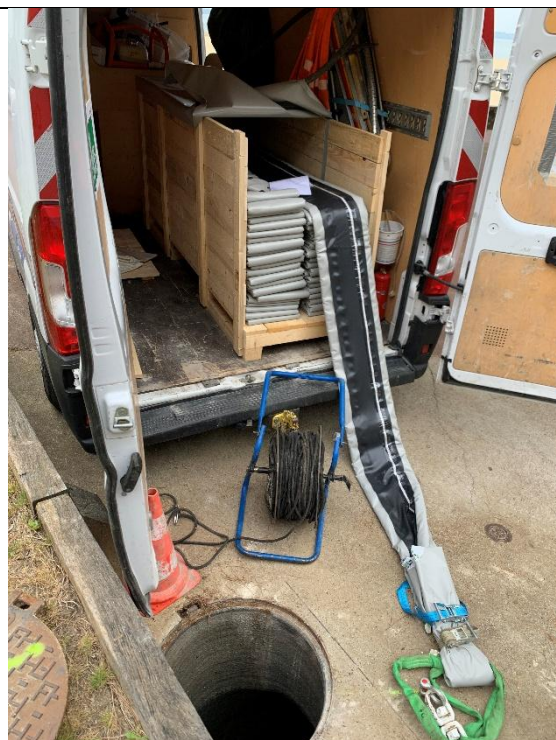
Mise en place de la gaine avant polymérisation par UV
