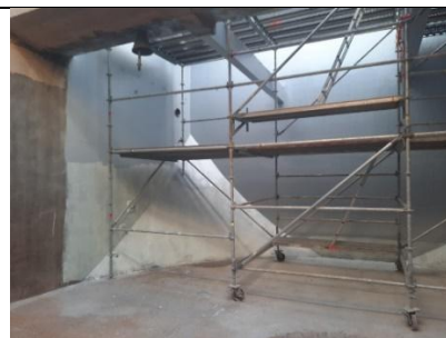
Mise en œuvre d'un système d'étanchéité adapté à l'environnement H_2S
