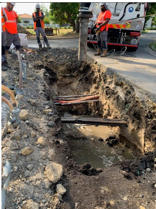
Terrassement à l'aide d'un camion aspiratrice pour le dégagement des réseaux
