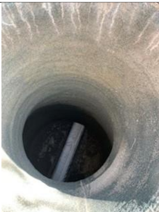
Regard de visite réhabilité par projection de béton
