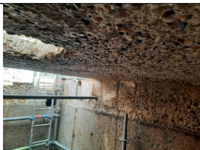
Dépose des équipements
