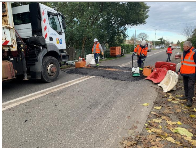
Mise en place du pompage provisoire pour le maintien du service de l'assainissement durant les phases de raccordement
