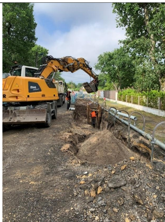
Vue de la tranchée avec présence du rabattement de nappe
