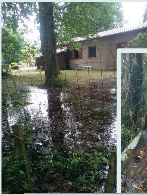
Inondation des propriétés en amont
