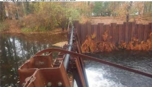
Ouvrage principal – cintrage important vers l'aval
