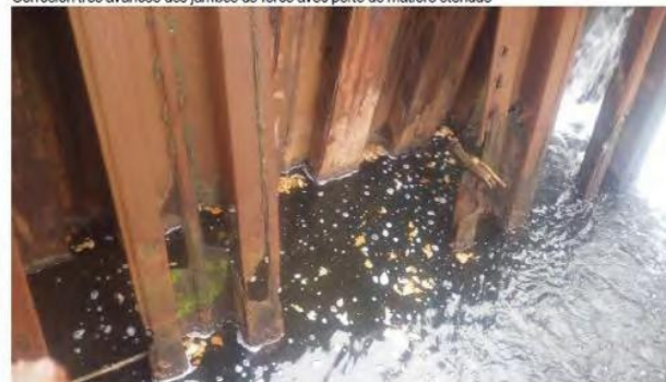
Ouvrage principal – cintrage important vers l'aval
