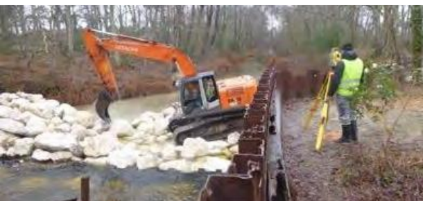
Travaux de mise en sécurité du Seuil Métallique n°3
