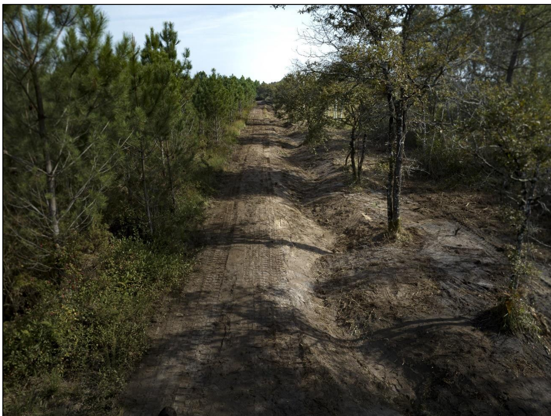
Figure 27 : Exemple de banquettes mises en place en amont du Vigneau en automne 2023.
