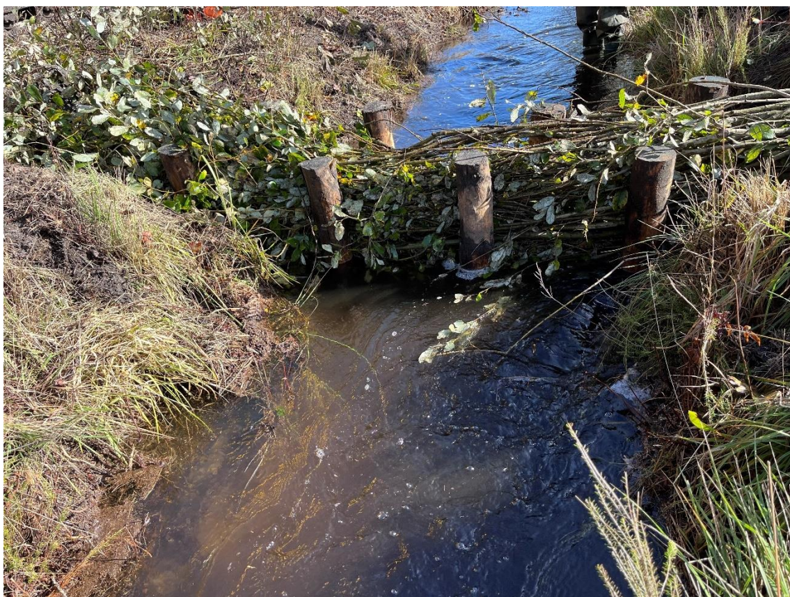
Figure 28 : Seuil en pieux bois installé en amont du Vigneau (automne 2023).
