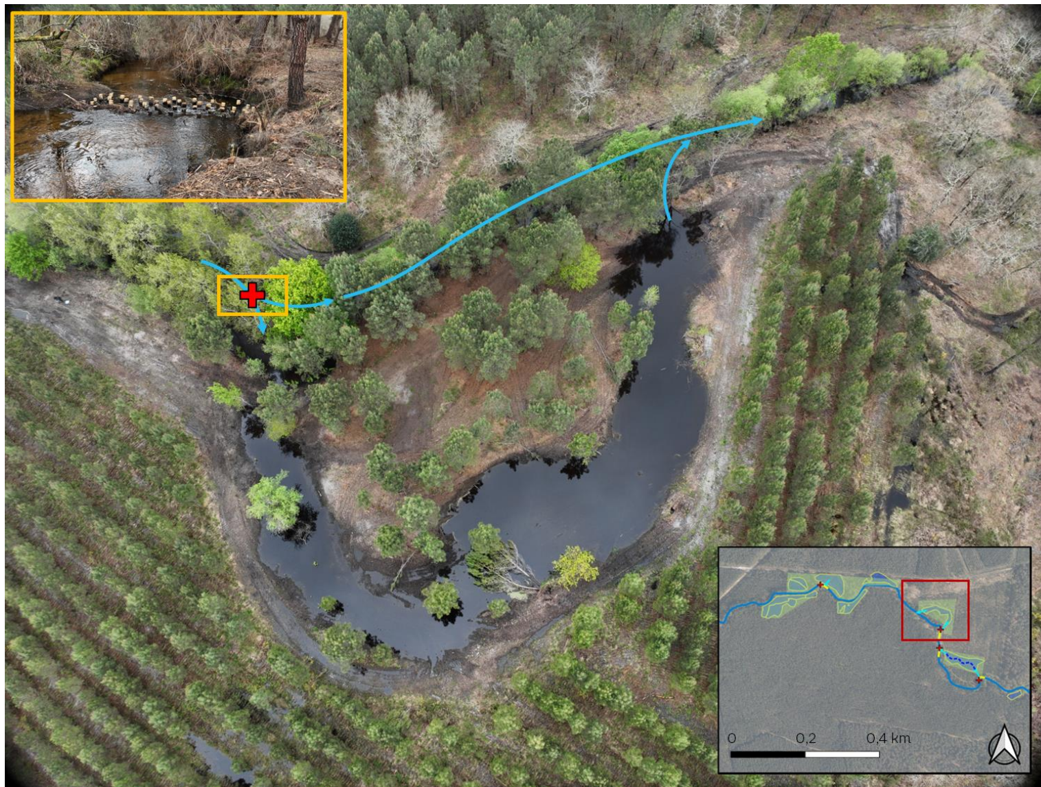
Figure 11 : Exemple de travaux d'aménagements réalisés en amont du Cirès (© SIBA - Avril 2025)
