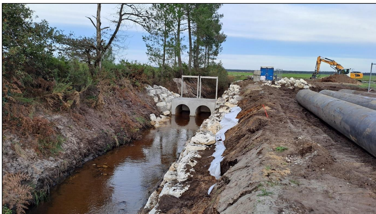
Figure 8 : Photo de l'ouvrage nord de la ZA de Blagon en position fermée
