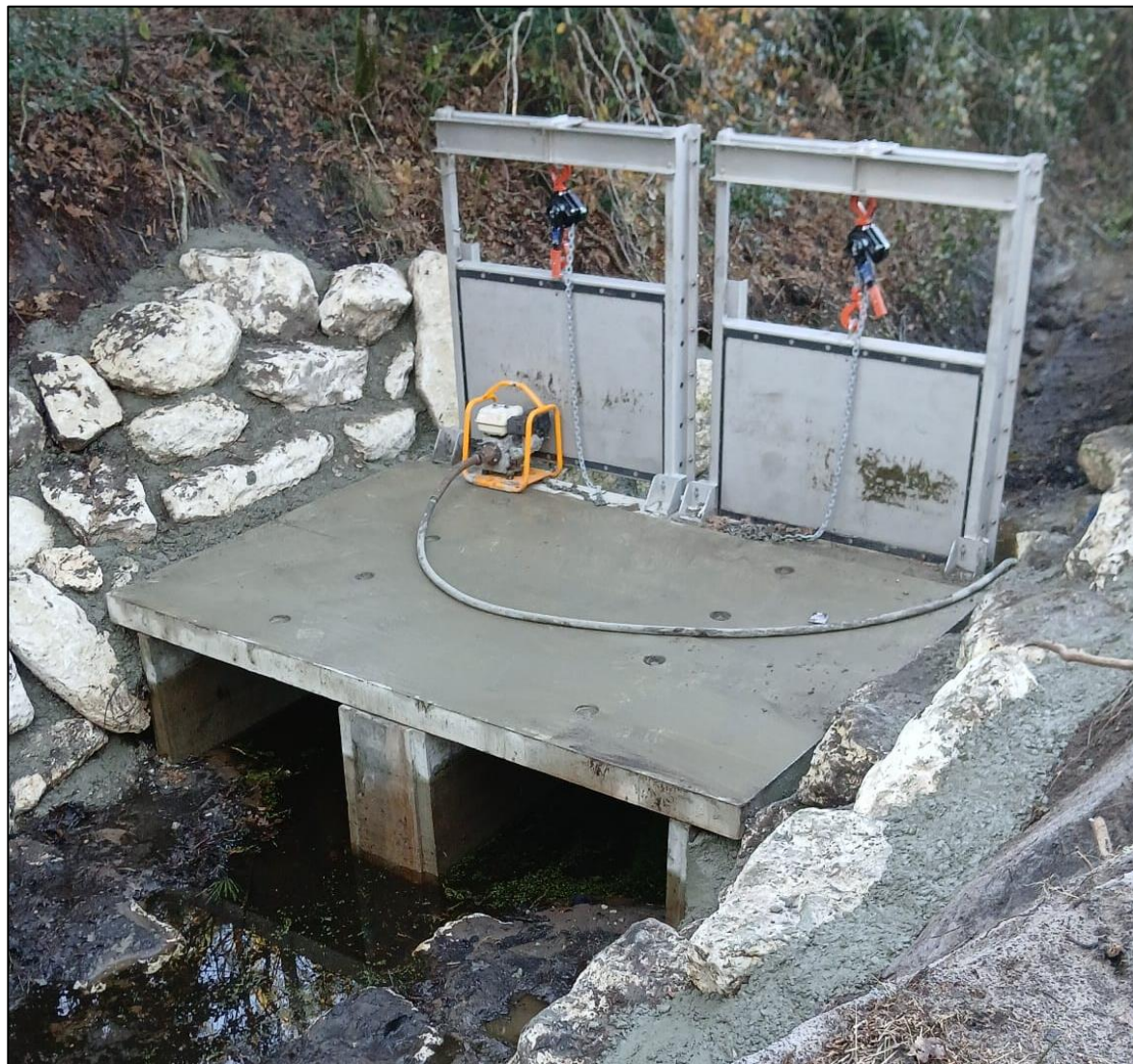
Figure 9 : Photo de l'ouvrage sud de la ZA de Blagon en position ouverte.
