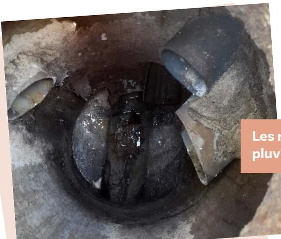
Les raccordements illicites d'eaux pluviales sur le réseau d'eaux usées
