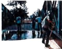
Point d'arrêt pour vérification des épaisseurs du primaire par le contrôleur ou le client.
