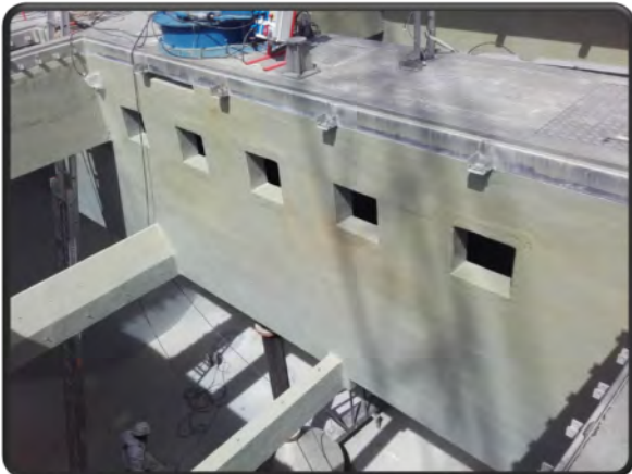
Rénovation du décanteur lamellaire de la tranche 1
