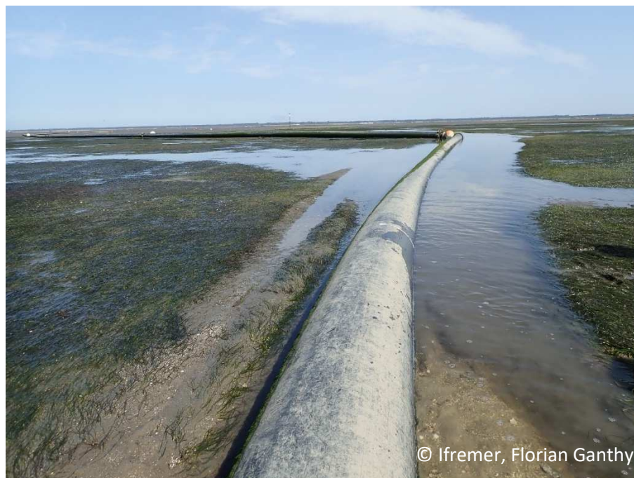
Figure 15 : Conduite de refoulement reposant sur l'herbier
