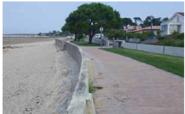
Illustration 36 : Muret de protection - Andernos-les-Bains
