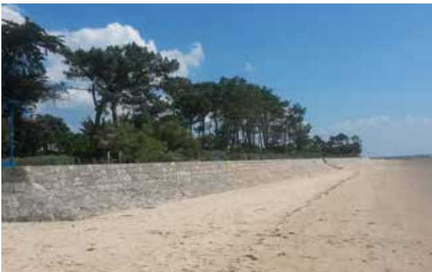
Illustration 35 : Couronnement de perré - Andernos-les-Bains
