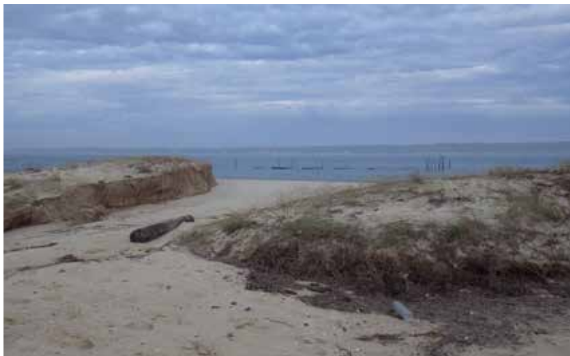
Illustration 25 : Illustrations de brèches dans la flèche sableuse du Mimbeau (tempête Hercule - 3 janvier 2014)
