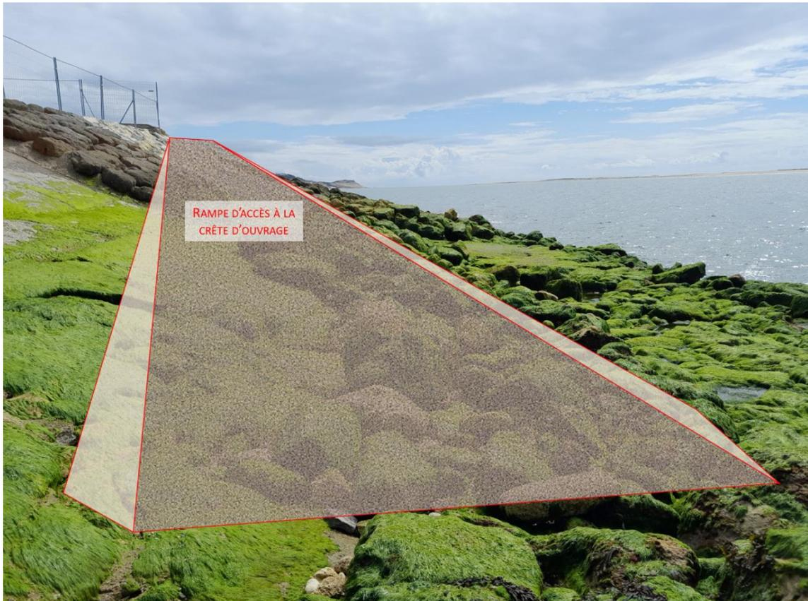
Figure 30 : Photomontage de la rampe d'accès à la crête d'ouvrage
