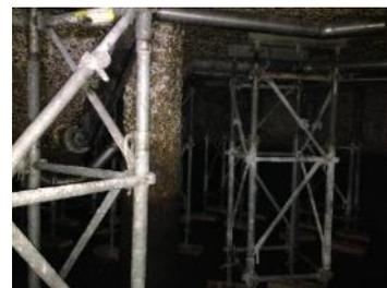
En mai 2013, les dernières mesures effectuées sur les bétons ont montré une accentuation importante des dégradations nécessitant une consolidation provisoire des ouvrages avec la mise en place d'étais.
