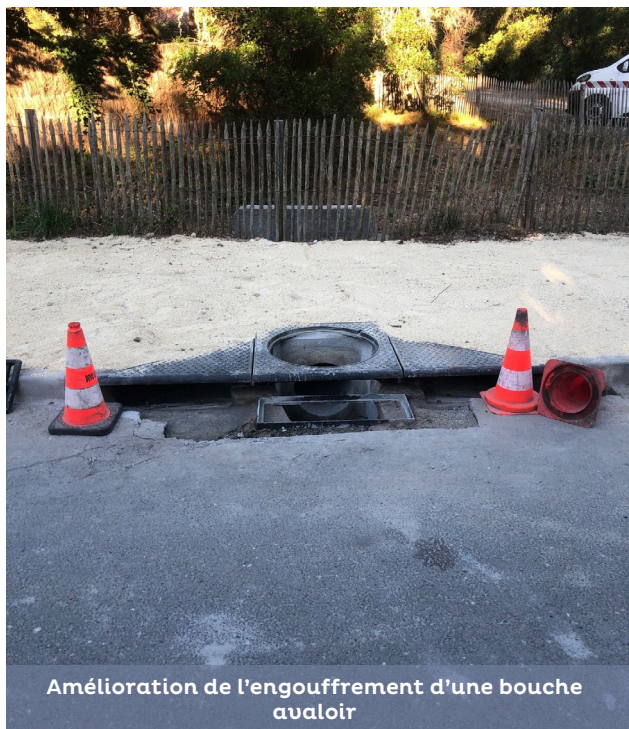
Renouvellement bouche engouffrement avec pose de pré-bouche
