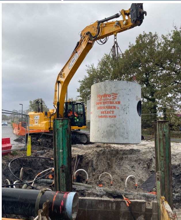
Mise en place de l'ouvrage de pré-traitement
