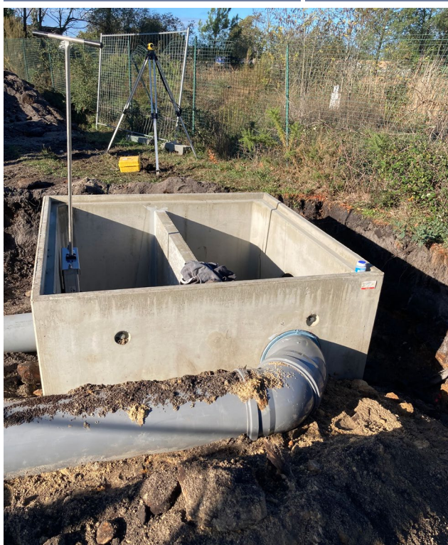
Pose de l'ouvrage de régulation aval
