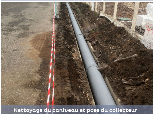
Lestage du collecteur préalable à la mise en place de la protection mécanique
