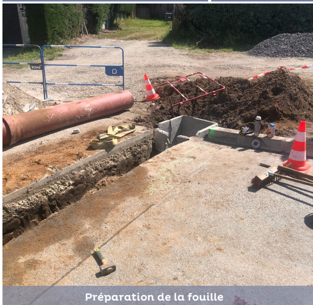
Nivellement du fond de fouille avant pose de la canalisation
