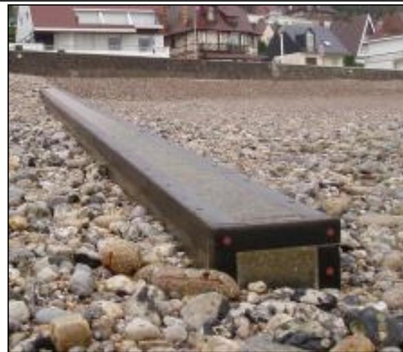
Structure métallique recouvert d'un parement béton
