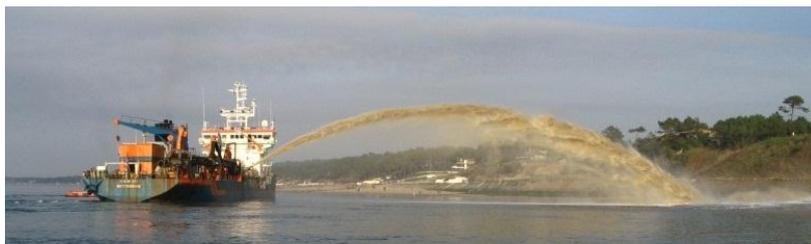
Figure 16. Rechargement du Pyla-sur-Mer par la méthode du rainbowing (SOGREAH 2006)
