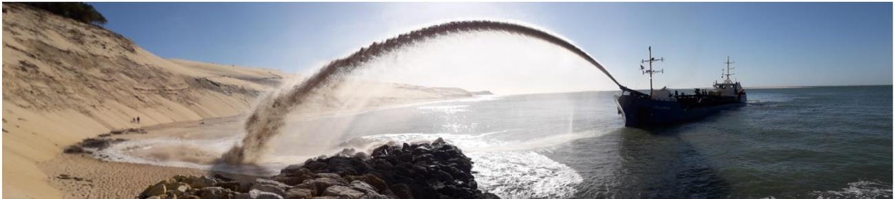
Figure 22: Opération test de réensablement en février 2020 sur le site (source : SIBA)
