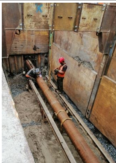
Opération de fonçage pour le passage sous le giratoire du Delta
