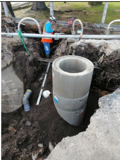
Vue de la tranchée – Raccordement sur l'existant et reprise du branchement au niveau de l'Allée Isabelle
