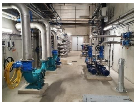
Galerie des pompes
