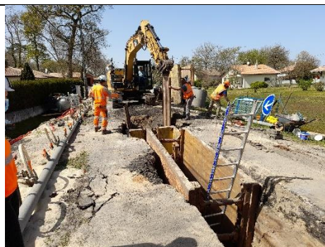
Vue de la tranchée et mise en place du blindage
