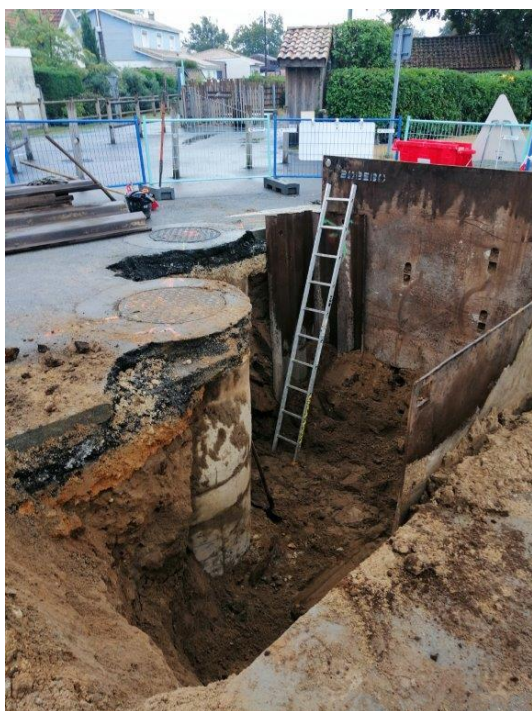
Vue de la tranchée au niveau de la piste cyclable
