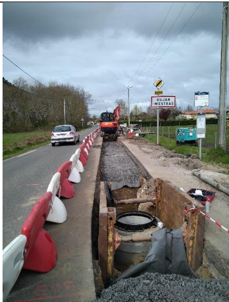
Vue de la tranchée et pose du regard intermédiaire
