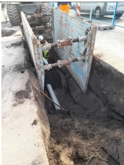
Vue de la tranchée – Avenue de la Côte d'Argent
