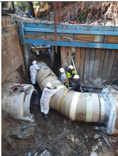
Vue du Ø1200 PRV pendant la phase de raccordement
