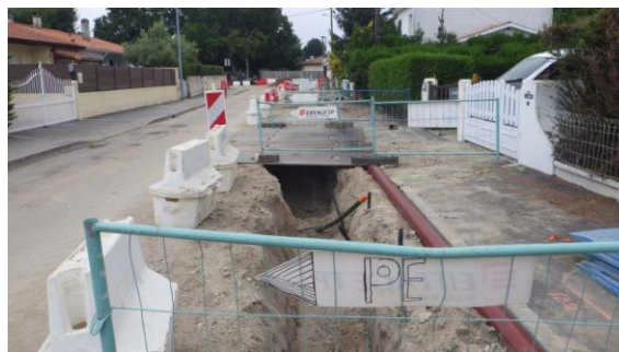
Vue de la tranchée
