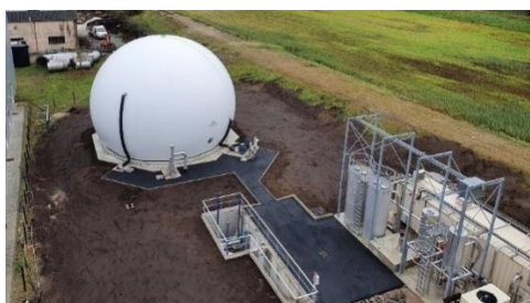
Gazomètre et unités d'épuration et de purification
