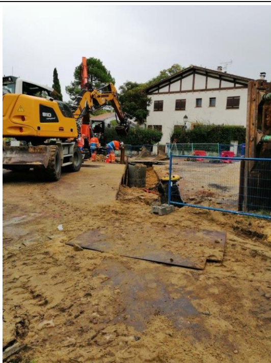
Vue de la tranchée – Allée Beethoven
