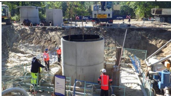
Opération de grutage du poste
