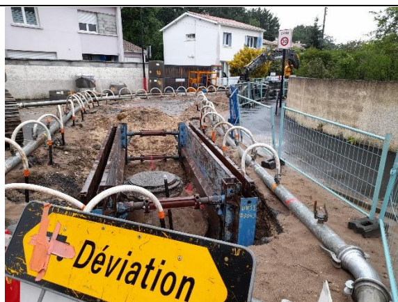
Vue de la tranchée
