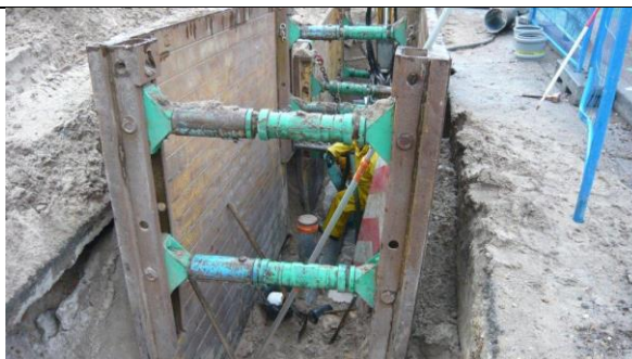
Vue de la tranchée avec blindage
