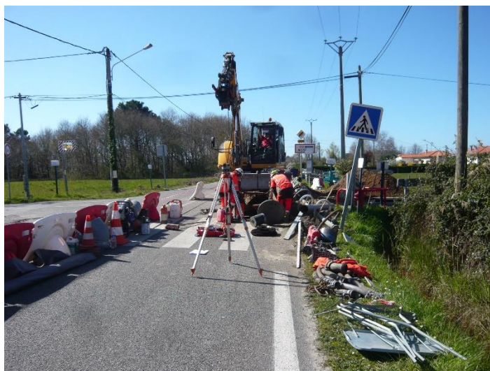
Vue du chantier – raccordement au réseau existant
