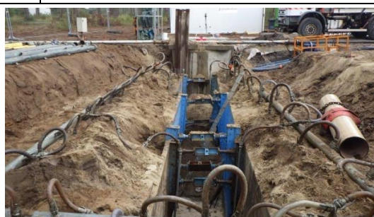
Raccordement du réseau gravitaire au poste
