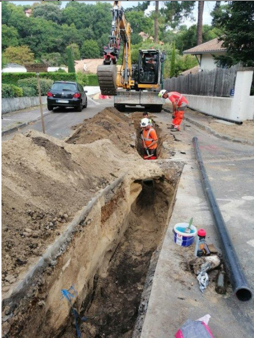
Vue de la tranchée – Pose du refoulement Ø110
