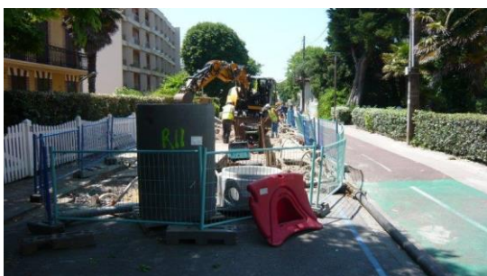
Vue générale du chantier
