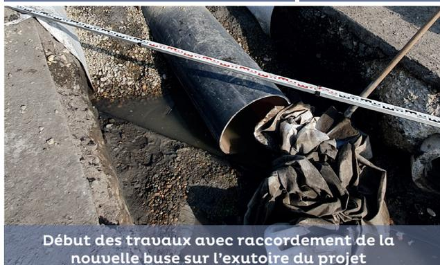
Début des travaux avec raccordement de la nouvelle buse sur l'exutoire du projet
