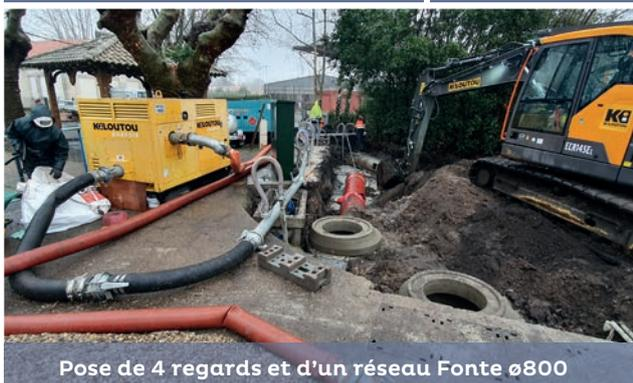
Pose de 4 regards et d'un réseau Fonte ø800
