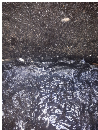
PR Vieux Port : Problème étanchéité fond du PR
