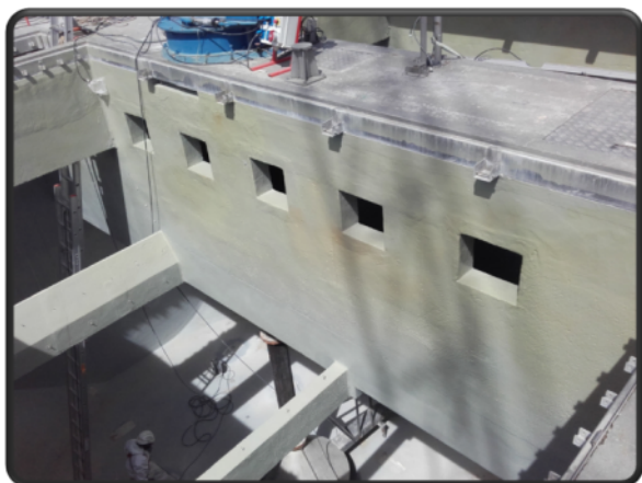
Rénovation du décanteur lamellaire de la tranche 1
