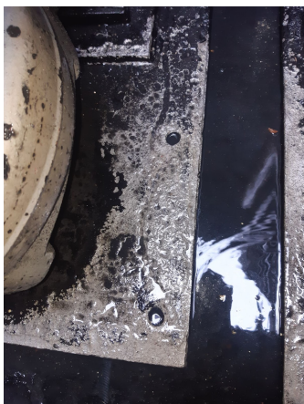
PR Vieux Port : Problème étanchéité fond du PR
