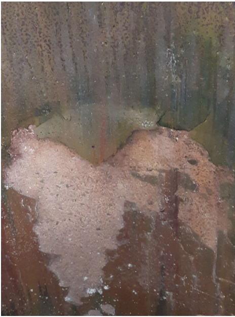
PR VVF : Dégradation du revêtement
