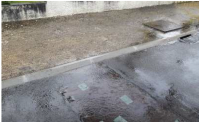
PR Armagnac 2 écoulement pluvial à revoir
