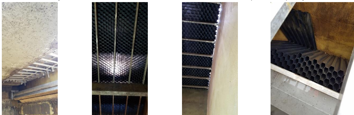
Ci-dessus, photos prises lors de l'inspection commune
