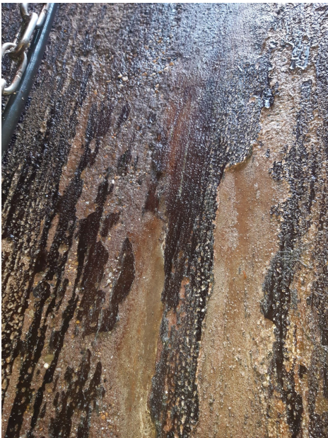
PR Chêneraie : Dégradation du revêtement
