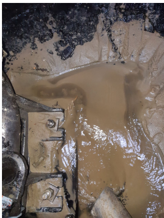
PR Mer et Soleil : Problème étanchéité fond du PR
