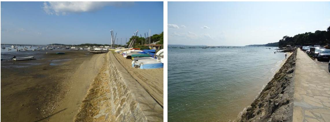
Figure 5. Perrés maçonnés rencontrés sur le littoral intra-bassin de Lège-Cap Ferret (CASAGEC, 2020).
