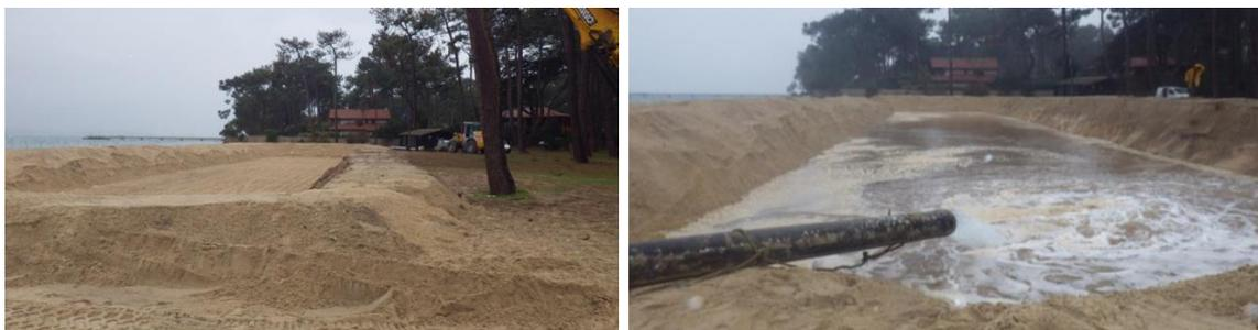
Figure 57 : Refoulement des sables de la Vigne sur le casier de décantation de la plage des Américains (SIBA ©2015).
