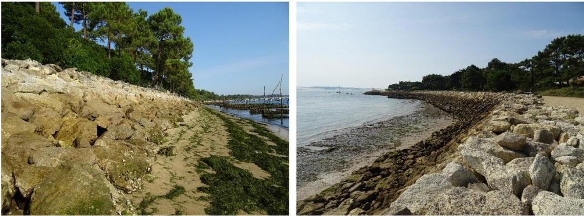
Figure 4. Enrochements rencontrés sur le littoral intra-bassin de Lège-Cap Ferret (CASAGEC, 2020).
