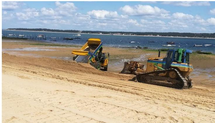
Figure 53. Illustration d'opération de rechargement sur le Mimbeau (© SIBA).
