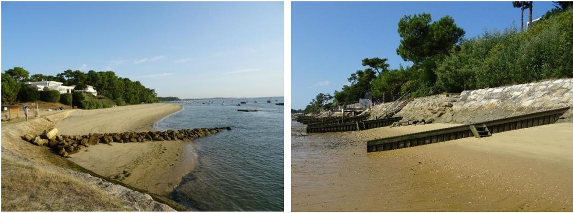
Figure 6. Epi (en enrochement ou en bois) rencontrés sur le littoral intra-bassin de Lège-Cap Ferret (CASAGEC, 2020).
