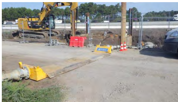
Vue du site de construction du poste
