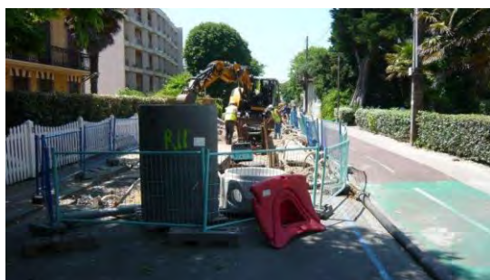
Vue générale du chantier
