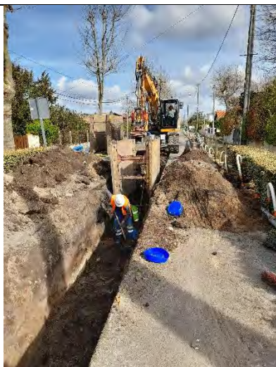
Vue de la tranchée entre l'avenue de la Libération et l'ancienne gare d'Arès
