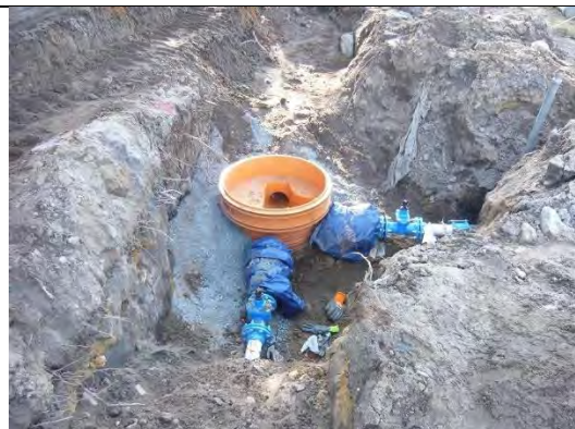
Vue du regard à l'exutoire de la conduite de refoulement
