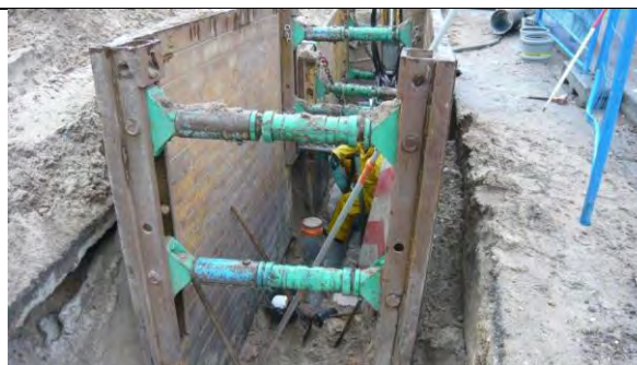
Vue de la tranchée avec blindage
