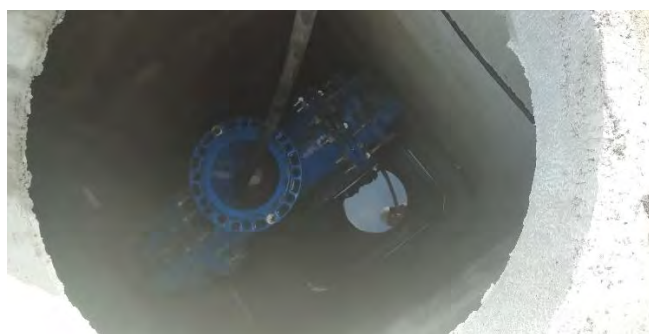
Vue de l'intérieur de l'ouvrage de curage au niveau du giratoire de l'avenue de la Libération
