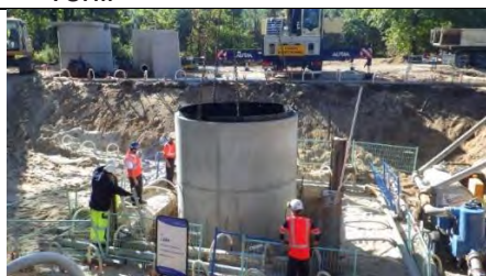
Opération du grutage du poste
