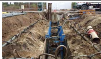
Raccordement du réseau gravitaire au poste
