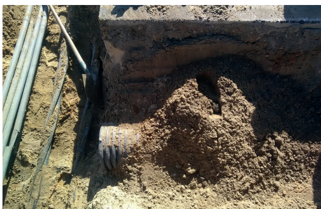
Terrassement pour raccordement au réseau
