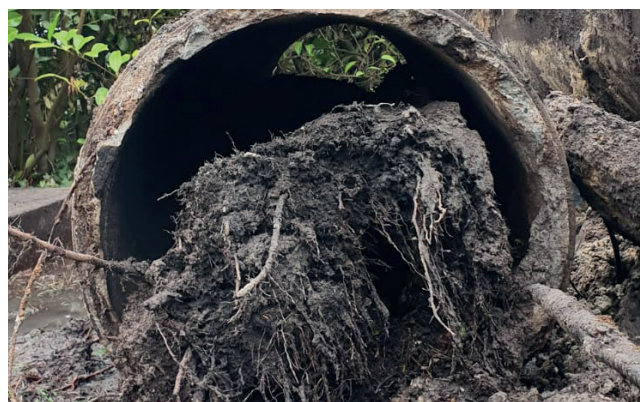
Renouvellement d'une canalisation suite au colmatage par des racines. Lège-Cap Ferret, Avenue de la Mairie
