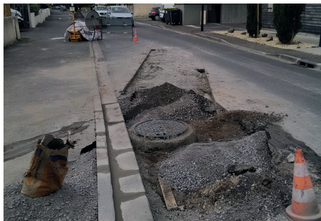
Réfection en cours
