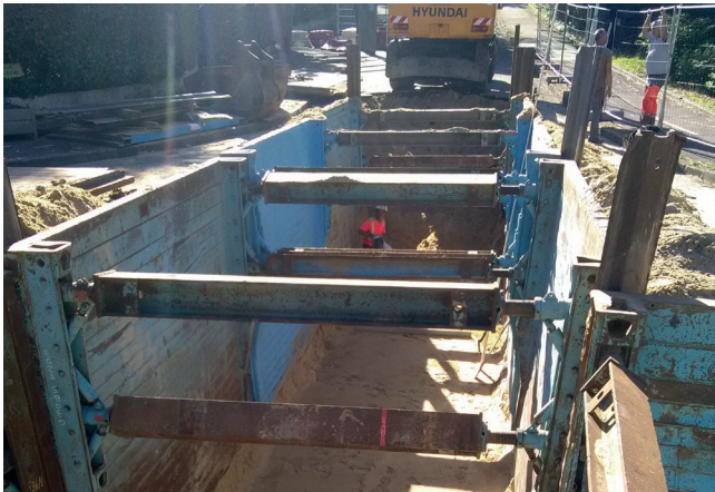
Pose des blindages avant la pose du SAUL
