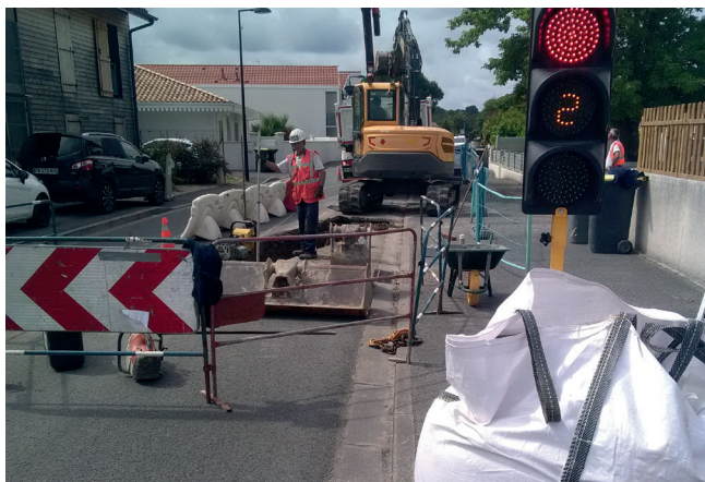
Terrassement pour la pose de caniveau béton
