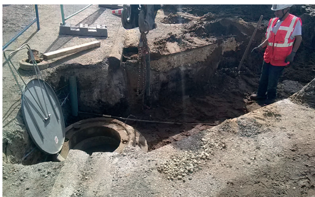
Réparation canalisation et regard, Allée de la Biotte, Gujan-Mestras
