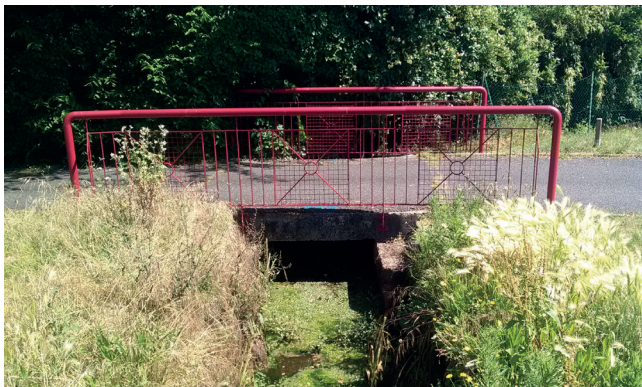
Ouvrage Hydraulique existant (sous dimensionné)
