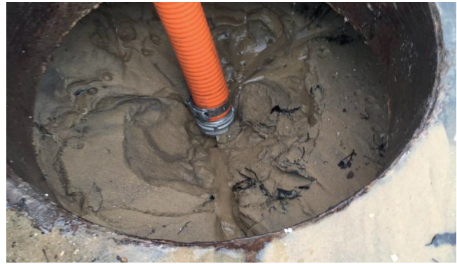
Hydrocuration regard décanneur : Arcachon
