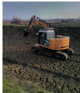
Prélèvement de sédiments dans le bassin de Verdalle et entreposage des big-bags sur le site du SIBA de Biganos avant enlèvement par le transporteur.
