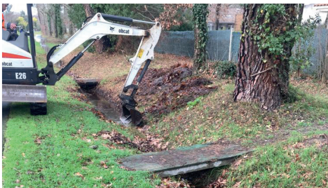
Curage de fossé Lanton
