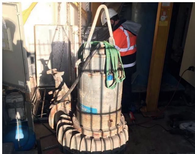
Poste de pompage de Florida, Arcachon : inspection volute pompe
