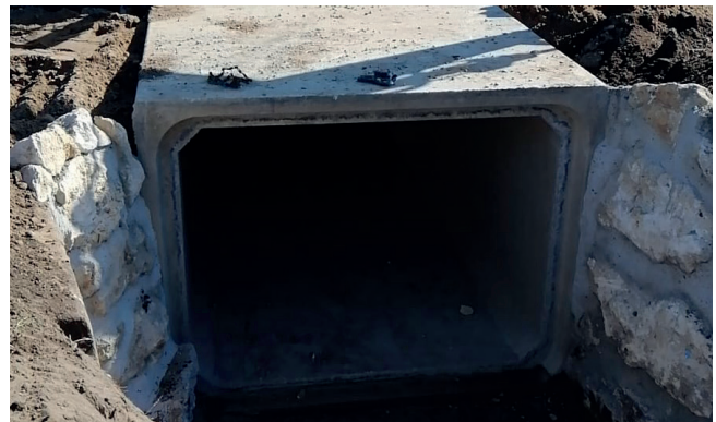
Construction d'un ouvrage cadre (2.00m * 1.50m) Terrassement pour la pose de caniveau béton
