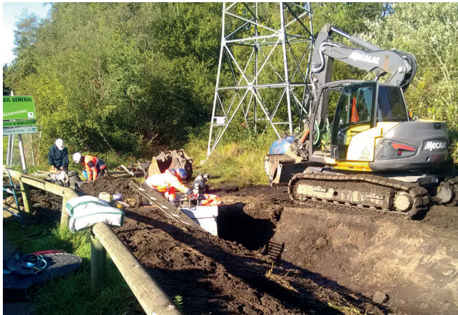
Pose d'un des regards
