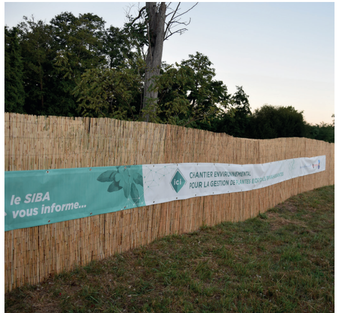
Zone de stockage confinée avec banderole « Chantier Environnemental »
