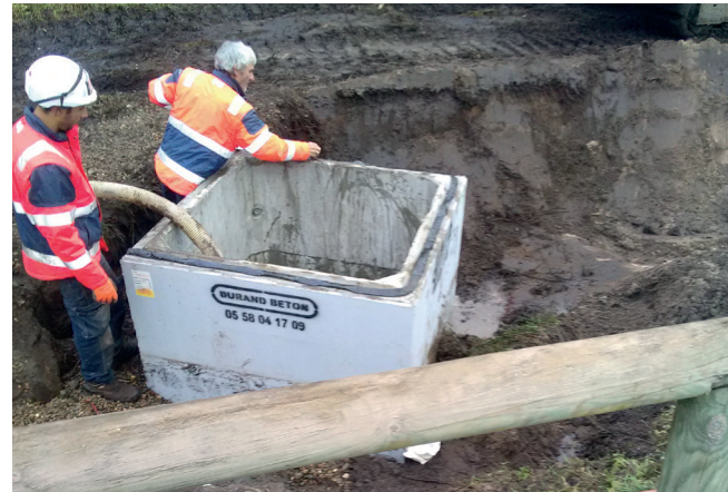
Préparation de la pose d'un regard
