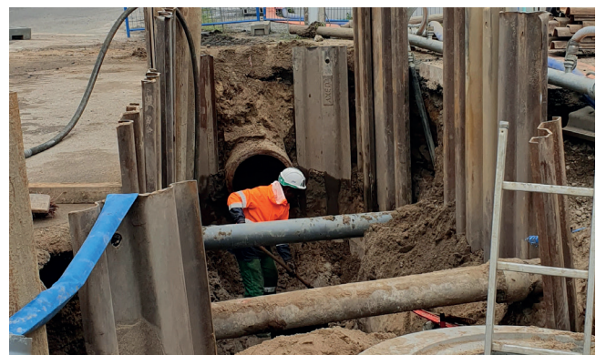
Pose de réseau en présence de la nappe
