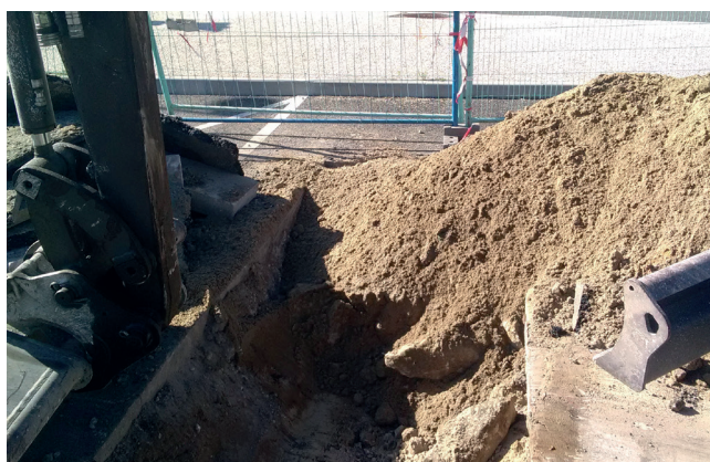
Aménagement d'ouvrages de récupération des eaux pluviales
