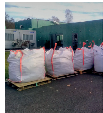
Prélèvement de sédiments dans le bassin de Verdalle et entreposage des big-bags sur le site du SIBA de Biganos avant enlèvement par le transporteur.
