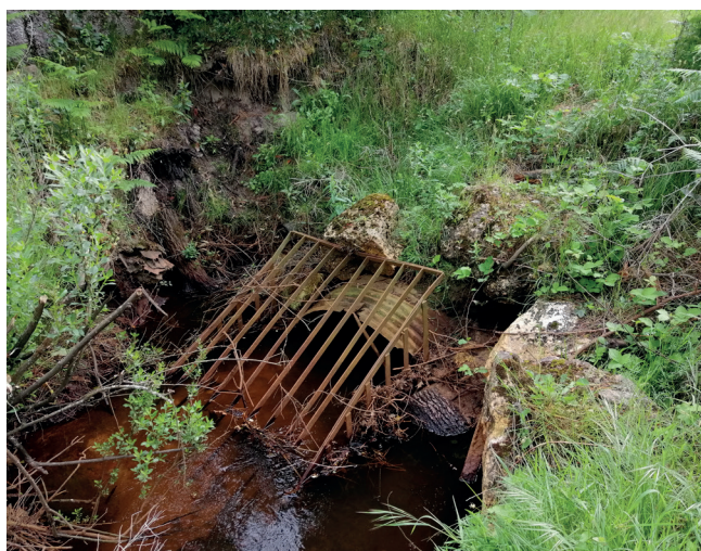
Vue du busage avec les sapements de talus à traiter
