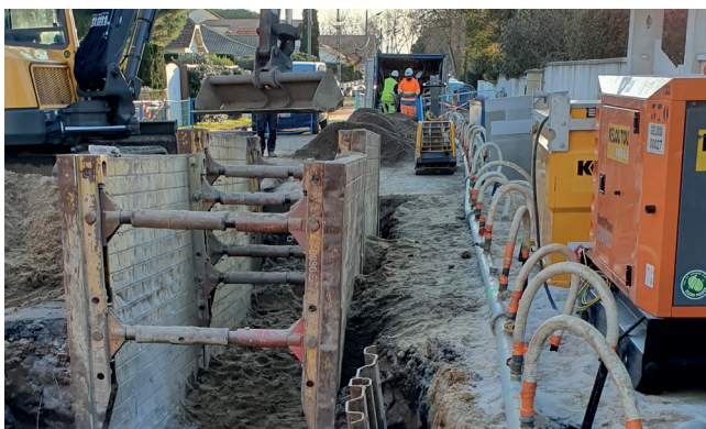
Pose de réseau en traversée de RD
