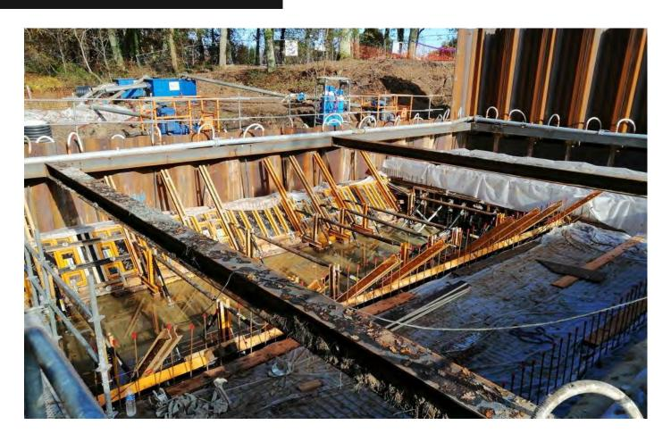
Sous l'ouvrage : un radier alternant entre 3.50 m de haut en amont de la chute et 1.70 m de haut en aval de la chute. Une profondeur de palplanche de 11.90 m.
