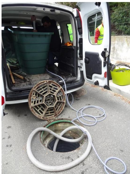
Figure 91. Injection de la saumure dans les événements.
