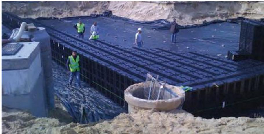
**Figure 8.** Commune de Lège-Cap Ferret. Bassin d'infiltration d'un volume de 770 m<sup>3</sup> pour la suppression d'un rejet d'eaux pluviales vers le milieu récepteur (en zone sensible de baignade et d'activité ostréicole), 2014 © SIBA.
