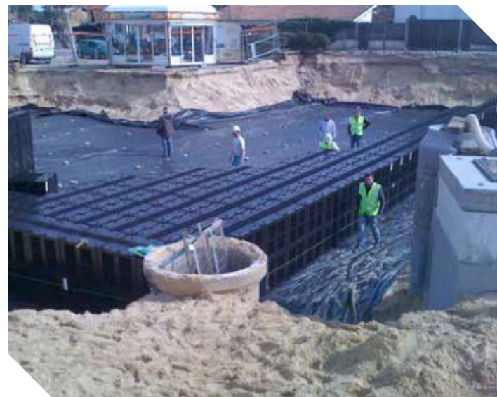
Figure 4. Bassin des eaux pluviales en construction (ici sur la commune de Lège-Cap-Ferret).
