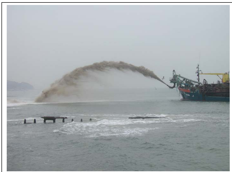
Ensablement de la plage du Pyla (Janvier 2003)
