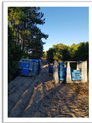
Installation de pompage (4+1 pompes et 2x800 m de Dn400)
