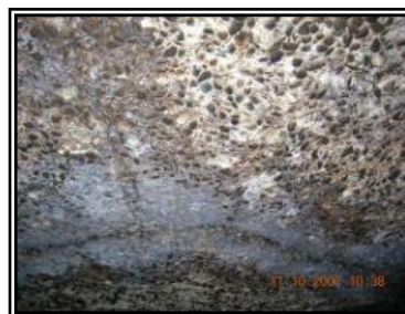
Fissures et dégradation apparentes des bétons
