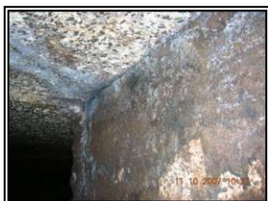
Fissures et dégradation apparentes des bétons
