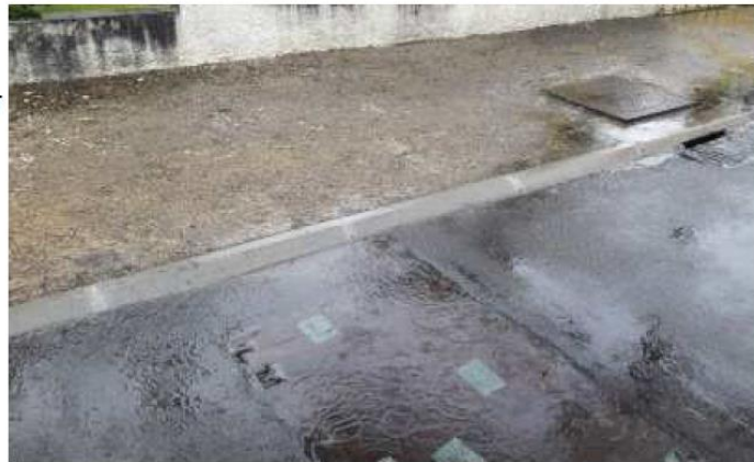
PR Armagnac 2 écoulement pluvial à revoir
