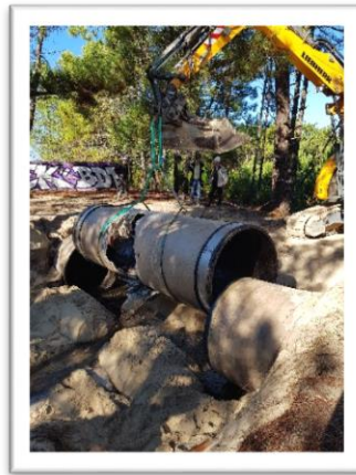
Travaux de réparation du collecteur
