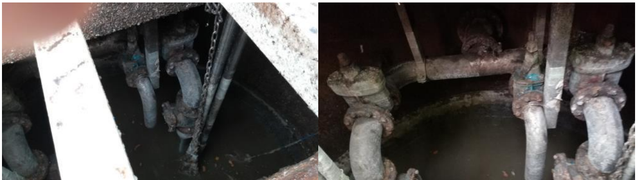
PR bourgeon – poste en mauvais état – hydraulique à refaire
