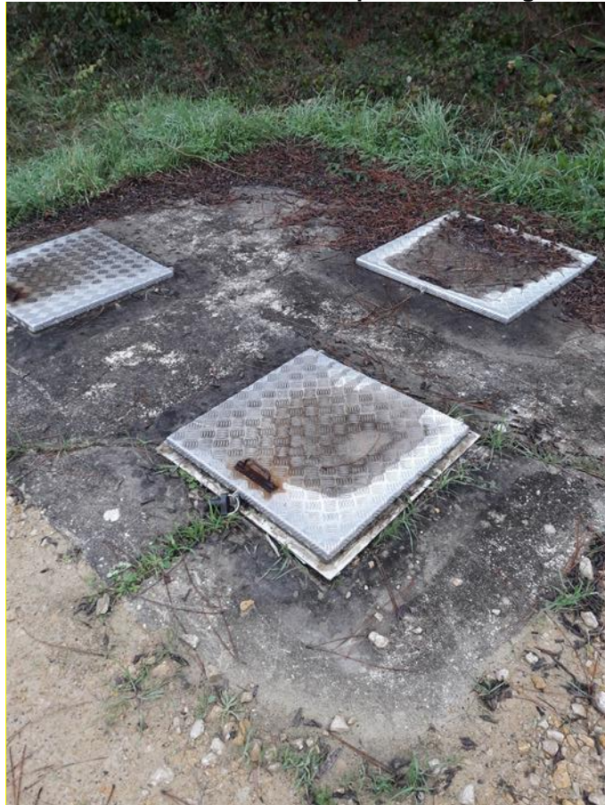
PR Les dunes –dalles dégradées à renouveler
