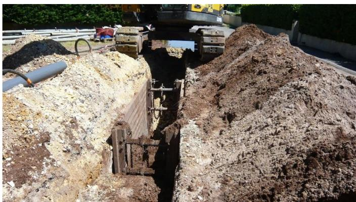
Vue de la tranchée blindée avant pose des canalisations
