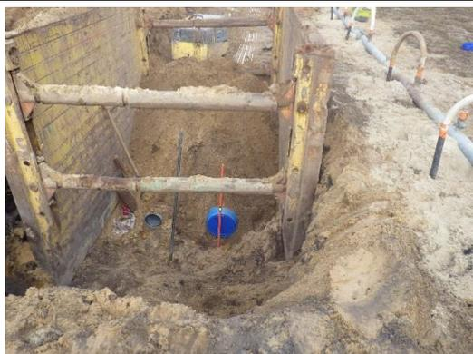
Vue de la tranchée blindée avec les deux nouvelles canalisations posées en parallèle
