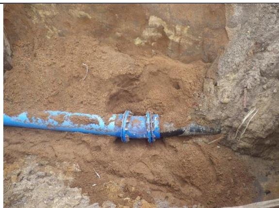
Vue de la nouvelle canalisation de refoulement raccordée
