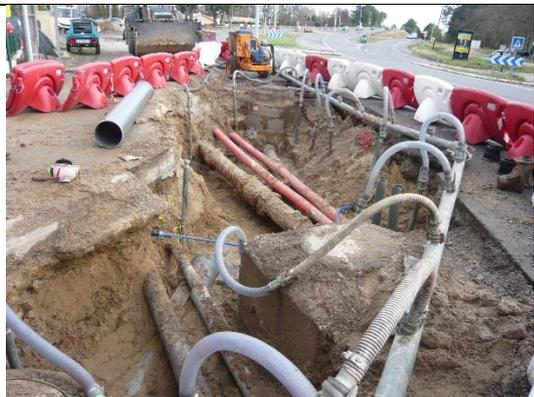
Vue de la tranchée avec croisement des réseaux au niveau de l'intersection entre le boulevard du Pyla et le chemin du Moulleau
