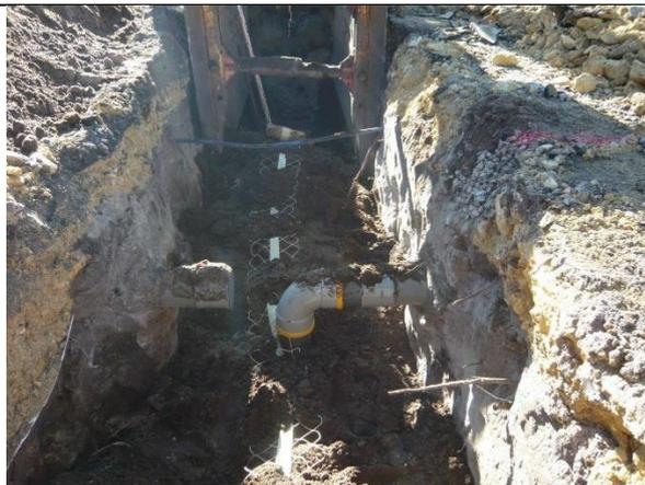
Vue de la tranchée avec reprise d'un branchement existant sur la nouvelle canalisation de la rue Saint Georges
