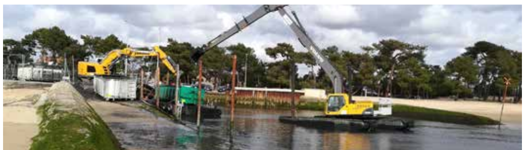
Pendant les travaux, chenal du Betey
