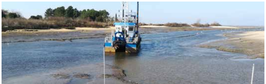
Pendant les travaux
