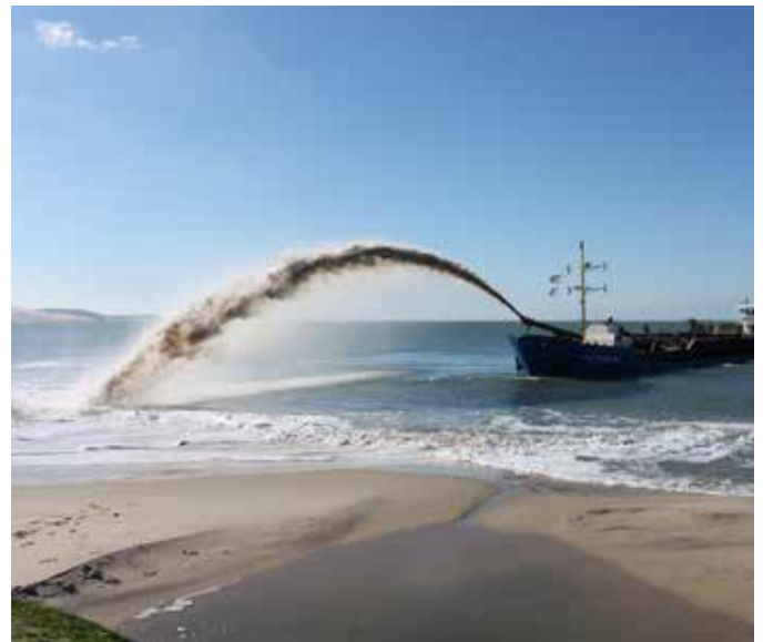
Pendant les travaux, Côte de Bretagne
