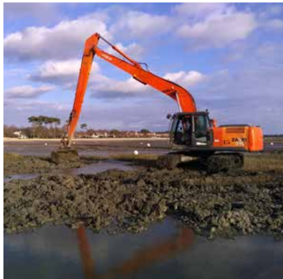
Chantier d'arrachage mécanique de la spartine anglaise
