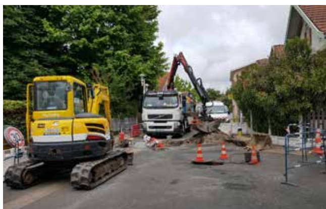
Travaux ponctuels de renouvellement de réseau, Lanton
