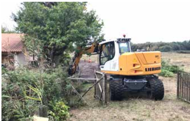
Curage de fossé en cours, Arès
