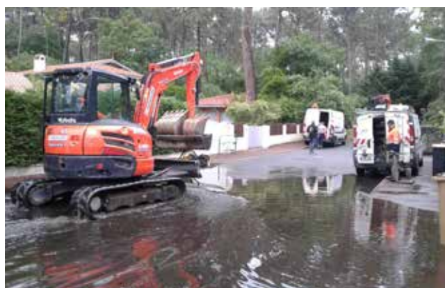
Travaux de création de réseau, Arcachon
