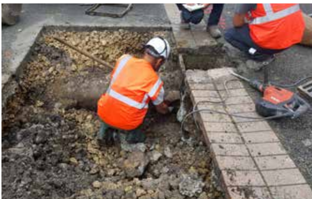
Réparations d'une casse réseau à Lanton, rue Guy Célérier
