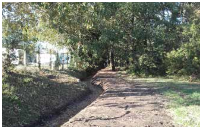
Remise en état après curage de fossé, Arès
