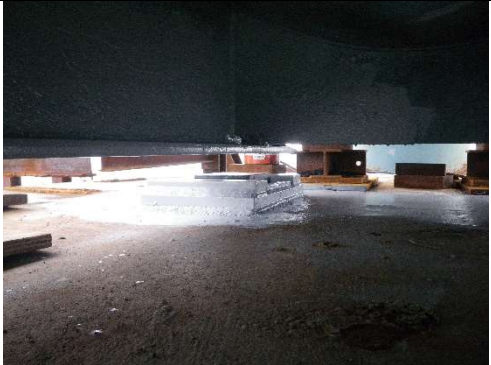
Appareil d'appui remplacé
