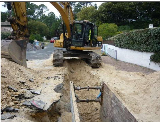
Vue de la tranchée au croisement du boulevard de Crêtes et du boulevard du Firmament
