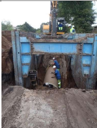
Pose des canalisations
