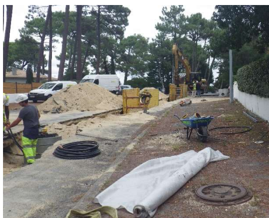
Vue de la partie terminale du chantier
