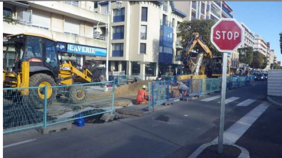
Vue générale du chantier sur le boulevard du général Leclerc
