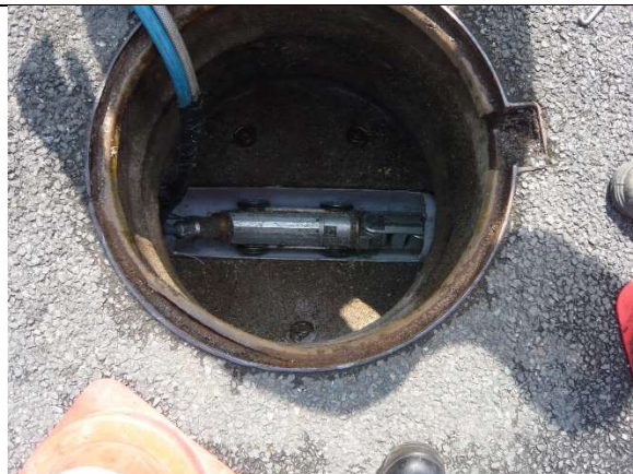
Vue du chariot tractant la gaine à l'intérieur de la canalisation
