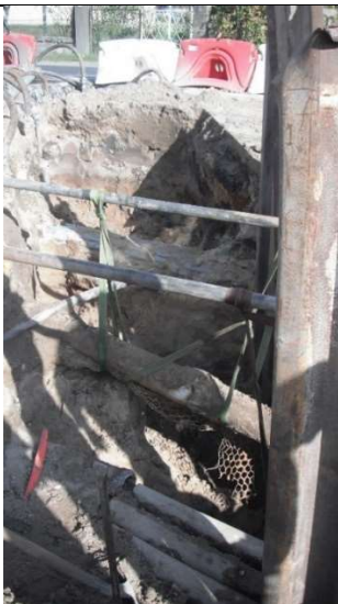
Vue des différents réseaux présents dans la tranchée au niveau du carrefour Avenue de la Libération / Route de la Plage
