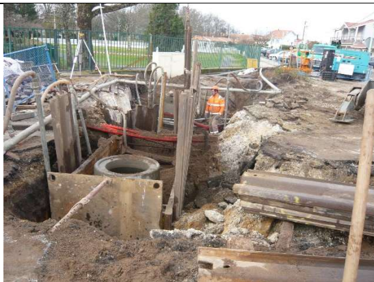
Vue de la tranchée en amont du poste de pompage « Mairie »
