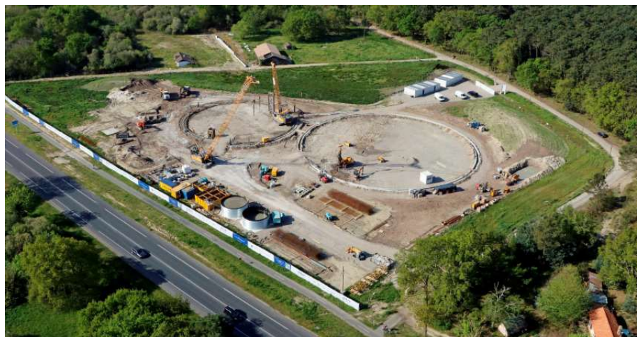
Situation des travaux – 04/2018
