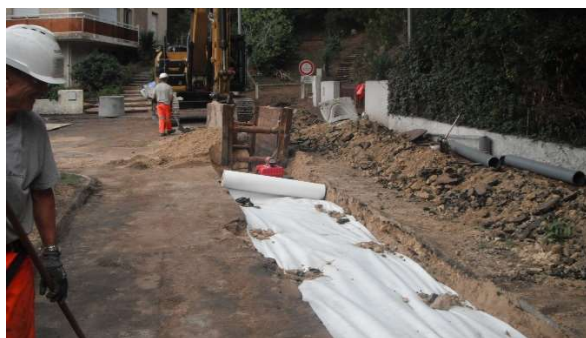
Vue du chantier au niveau de l'allée des Fougères
