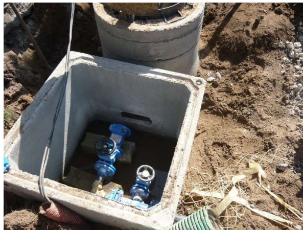
Vue de la nouvelle chambre à vannes
