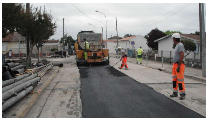
Vue de l'opération de réfection de la voirie après travaux
