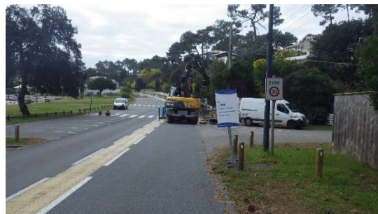
Vue du démarrage des travaux sur l'avenue de la Vigne
