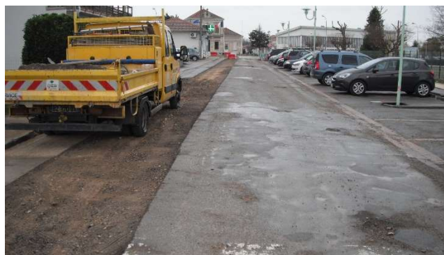
Vue du rabotage des enrobés à l'emplacement du futur réseau
