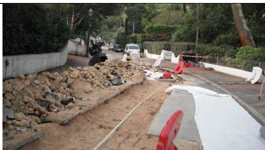
Vue du grillage avertisseur au droit de la nouvelle canalisation « eaux usées » avant remblayage définitif
