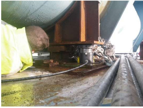
Vérinage de l'ouvrage
