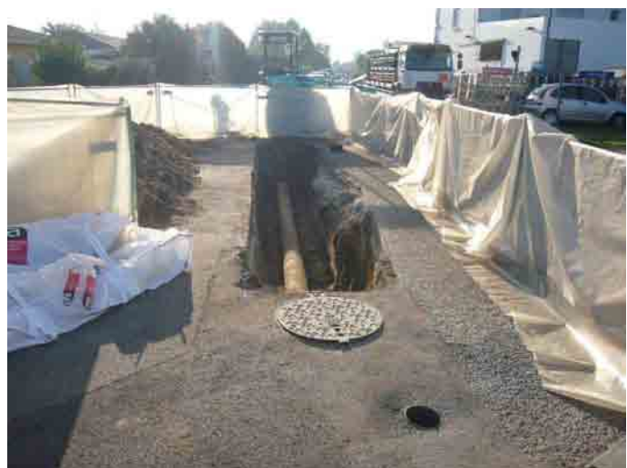
Vue de l'ancienne canalisation en amiante-ciment avec mise en place du périmètre de protection conformément à la réglementation
