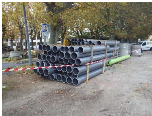
Vue des canalisations PVC Ø315 à poser
