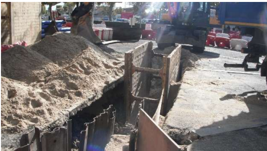
Vue de la tranchée avec blindage au niveau du giratoire de la poste
