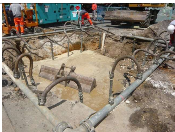
Vue de la tranchée pendant l'opération de rabatement de la nappe
