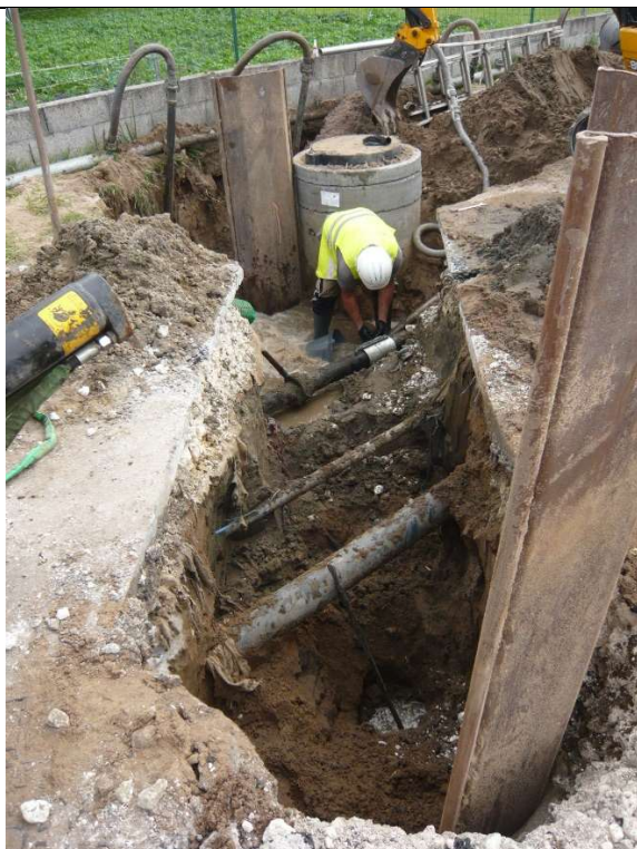
Vue de la tranchée et du futur poste de pompage avec rabattement de nappe
