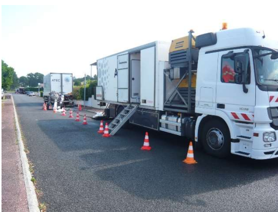
Vue de l'atelier pendant l'opération de chemisage de la canalisation de collecte
