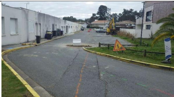
Vue du démarrage des travaux sur l'allée des Teinturins
