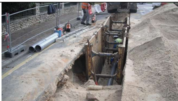
Vue de la tranchée avec blindage
