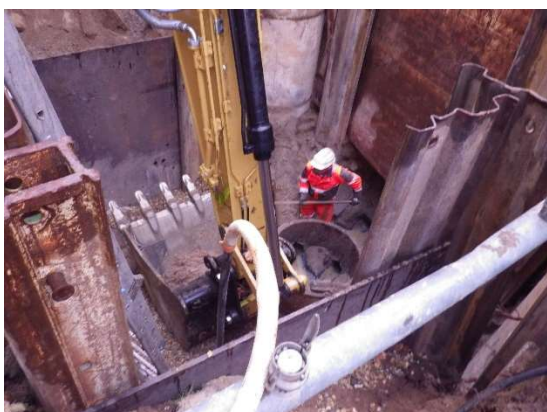
Vue de la tranchée pendant la pose du regard juste en amont du poste de pompage « Place du Marché »
