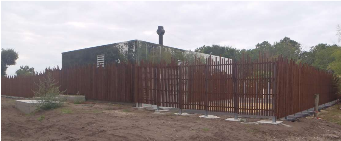
Poste de pompage Taussat Gare - Lanton
