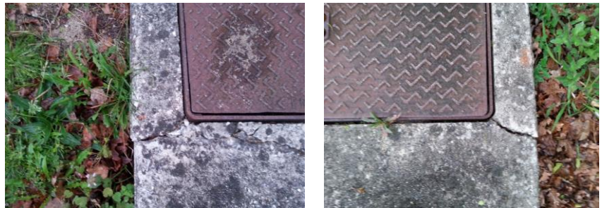
PR Piquey 1 dalle du PR fendue
