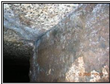
Fissures et dégradation apparentes des bétons
