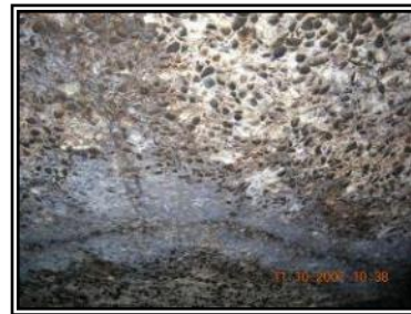
Fissures et dégradation apparentes des bétons
