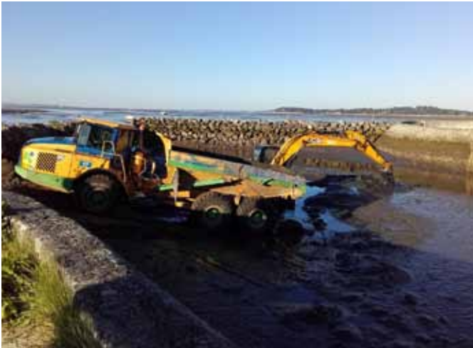
Extraction des sédiments dans le port
