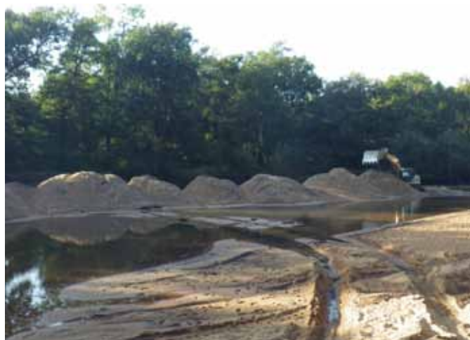
Chantier en cours
