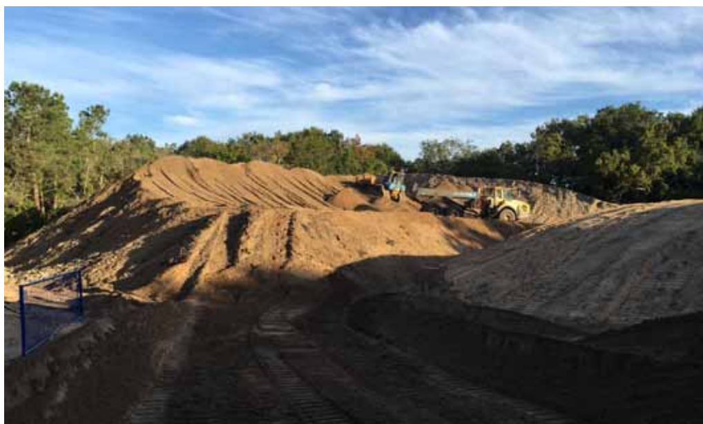
Plateforme de stockage
