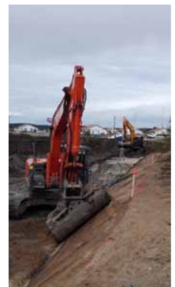
Construction du bassin de stockage
