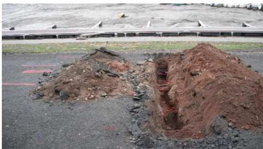
Réalisation de sondage afin de déterminer l'emplacement exact de la future canalisation
