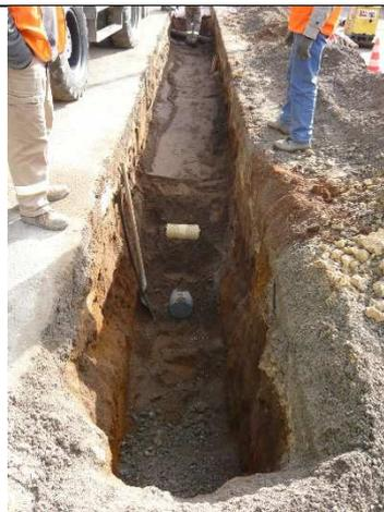
Tranchée en cours de remblaiement avec vue de la nouvelle canalisation et du grillage avertisseur
