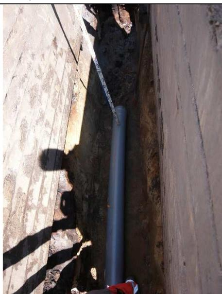
Vue de la tranchée blindée et de la nouvelle canalisation
