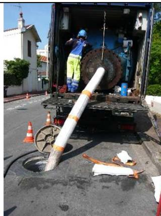
Vue de la gaine gonflée à l'air et prête à être polymérisée (phase de durcissement de la gaine à l'intérieur de l'ancienne canalisation)
