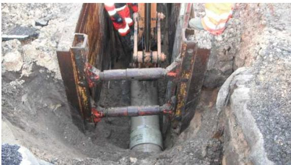
Vue de la nouvelle canalisation en PRV dans une tranchée blindée
