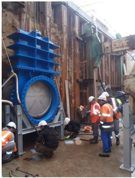
Détail d'une vanne d'arrivée des effluents
