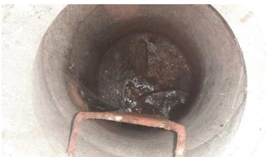
Exemple d'angle d'écoulement trop « fermé »
