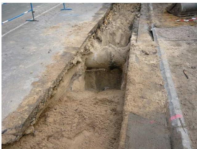
**Vue de la tranchée avec croisement d'un réseau d'eaux pluviales**
