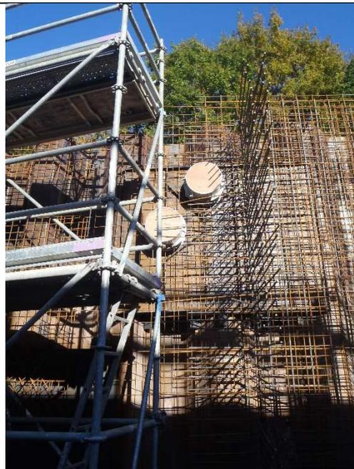
Détail du ferrailage d'un voile
