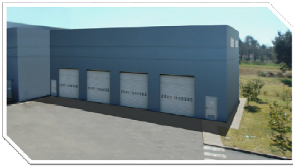
Nouveau bâtiment de La Teste de Buch
