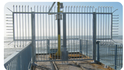
Nouveau portail situé au bout du Wharf
