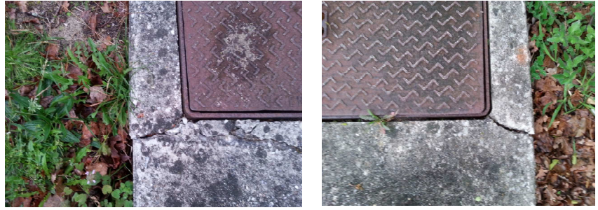
PR Piquey 1 dalle du PR fendue
