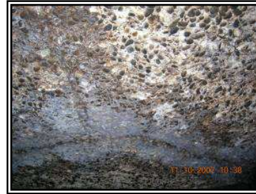
Fissures et dégradation apparentes des bétons
