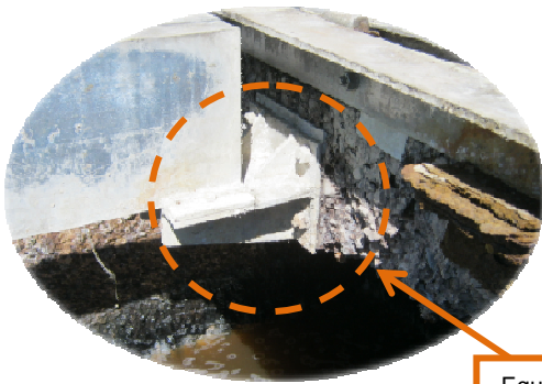
Dégradation des bétons de la dalle de la bâche de relevage
