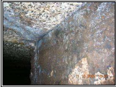
Fissures et dégradation apparentes des bétons
