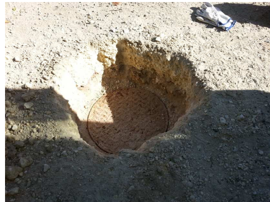
PR Le Four 1 PR recouvert de 30 cm de grave
