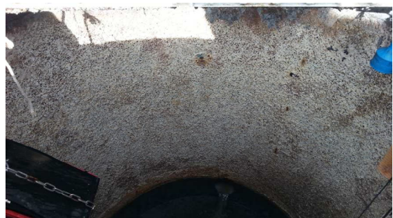
PR Malakoff dégradation du béton de la bêche
