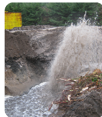
Fuite sur le refoulement de la ZI
