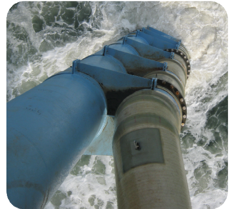
Nouveau de tuyau de descente en PRV
