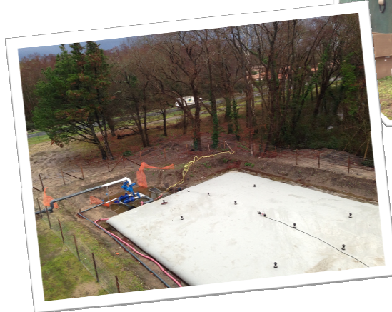
Bâches et hydrauliques provisoires permettant le déviation des effluents (boues, eaux sales, graisses, sables)
