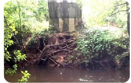
Déchaussement du pilier rive gauche
