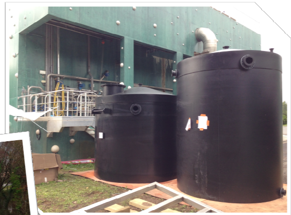
Bâches et hydrauliques provisoires permettant le déviation des effluents (boues, eaux sales, graisses, sables)
