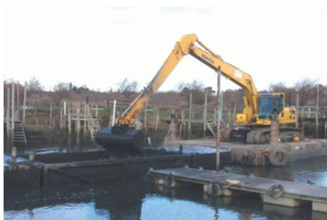
1 - La pelle creuse le port et charge les sédiments sur une barge flottante
