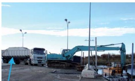
3 - Une autre grue décharge les barges et dépose les sédiments dans un camion étanche.
