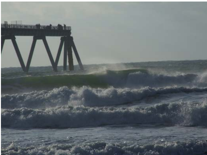
Figure 13 : déferlement autour du Wharf
