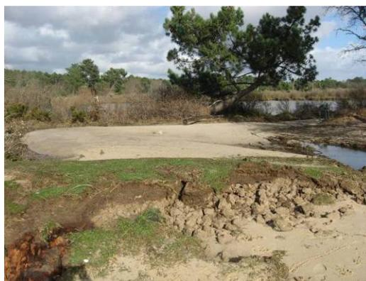
*Figure 33 : Déracinement des pins, dépôt de sable avec figures de courant et érosion de la digue entre Saint Brice et la Pointe des Quinconces (Andernos)*
