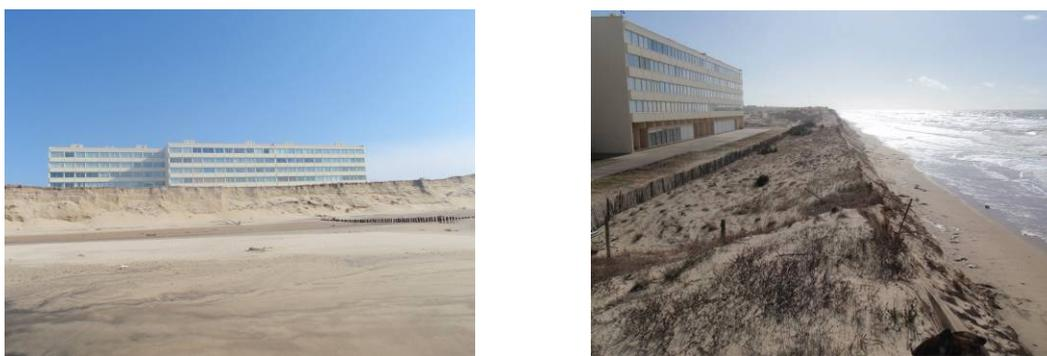
Figure 3 : Recul important face au bâtiment « Le Signal », Commune de Soulac-sur-Mer
