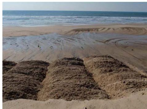
Figure 14 : La commune profile la plage et réengraisse le front de mer érodé entre les épis
