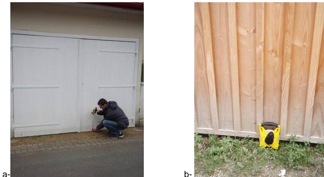
*Figure 24 : Traces visibles du niveau d'eau atteint par la submersion marine : a - 10 cm dans le village de l'Herbe ; b - 20 cm dans le village du Canon*
