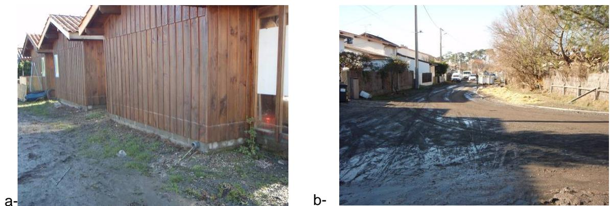
Figure 38 : Port de Taussat, allée des Cabanes : a – 45 cm mesurés ; b – Dépôt de vase
