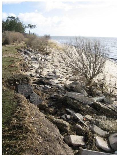
*Figure 32 : Erosion de la digue entre la conche de Saint Brice et la Pointe des Quinconces (Andernos)*
