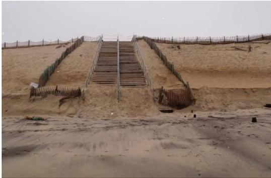
Figure 10 : Hourtin : escalier plage déstabilisé à sa base
