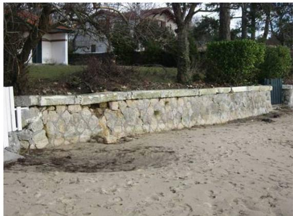
Figure 28 : Perrés détruits ou endommagés sur le front de mer d'Arès
