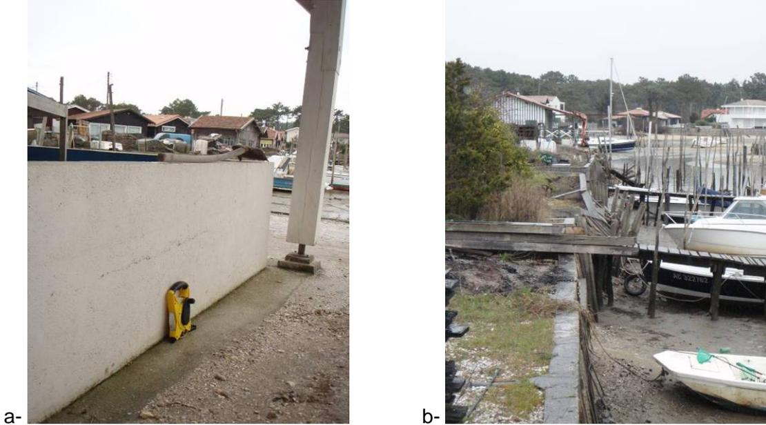
Figure 25 : Village de Pirailan : a – Niveau d'eau mesuré de 46 cm ; b – Quais endommagés
