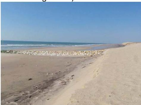
Figure 13 : Premier épis de Montalivet : pas de berme, ni de barre intertidale visible
