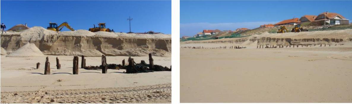
*Figure 18 : Mimizan plage, fort abaissement du niveau de la plage, des pieux anciens réapparaissent (ils ont déjà été vus dans les années 1950). Sur le haut de plage (à l'arrière de la falaise récente), les engins dessablent les brise-vents qui bloquent le sable en transit pendant l'hiver*
