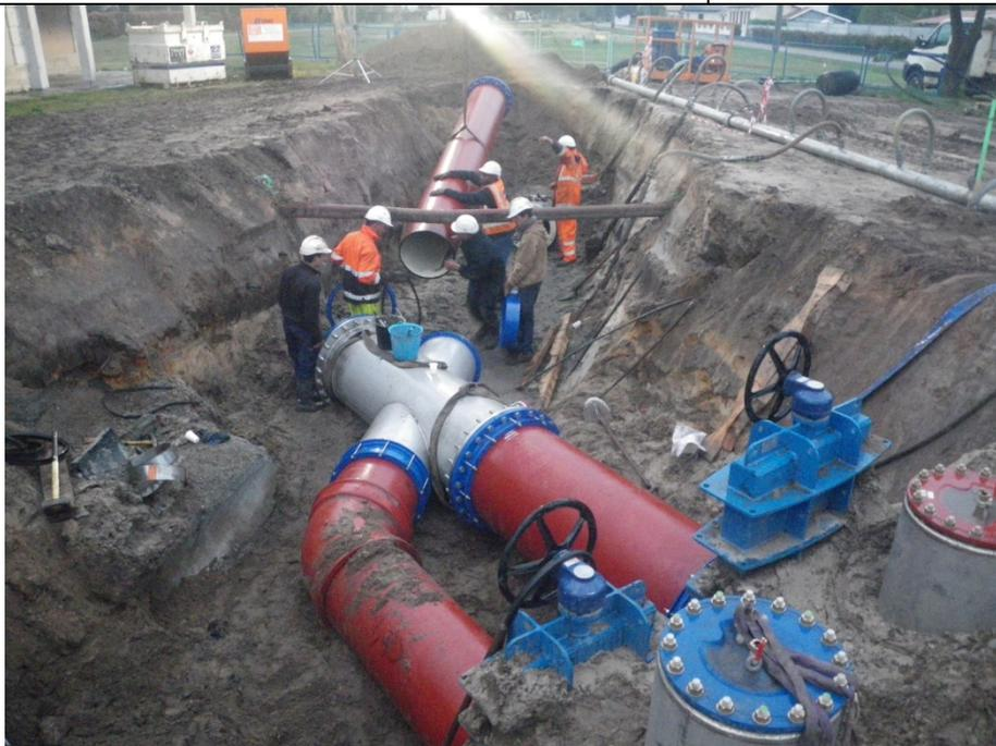
Détail de la pièce de raccordement des canalisations en fonte  $\varnothing$  600 et  $\varnothing$  800 mm
