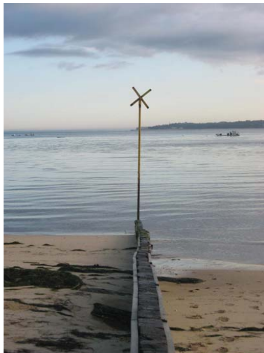
Vue de profil de l'effet d'un épi (à Lège-Cap Ferret)
