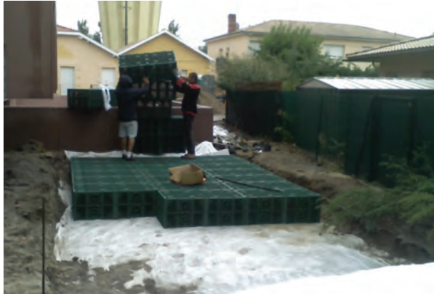
Stockage et infiltration des eaux de toitures d'une résidence, Commune de Lège-Cap Ferret : Réduction des inondations sous espace vert
