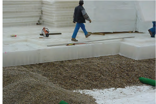
Stockage et infiltration des eaux de toitures d'une résidence, Commune de Lège-Cap Ferret : Réduction des inondations sous espace vert
