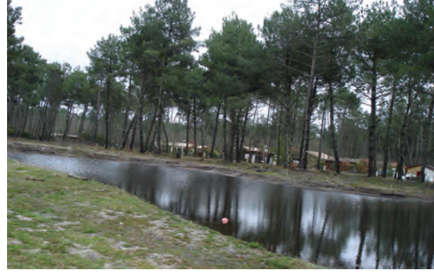
Noue en site « sable des Landes » avec présence de la nappe pédologique à faible profondeur, fonction : stockage, infiltration, régulation.
