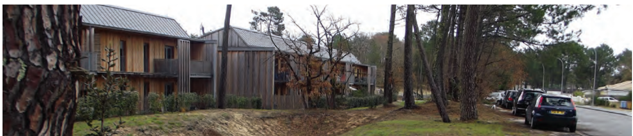
Noue en site « sable des Landes » avec présence de la nappe phréatique à faible profondeur.
