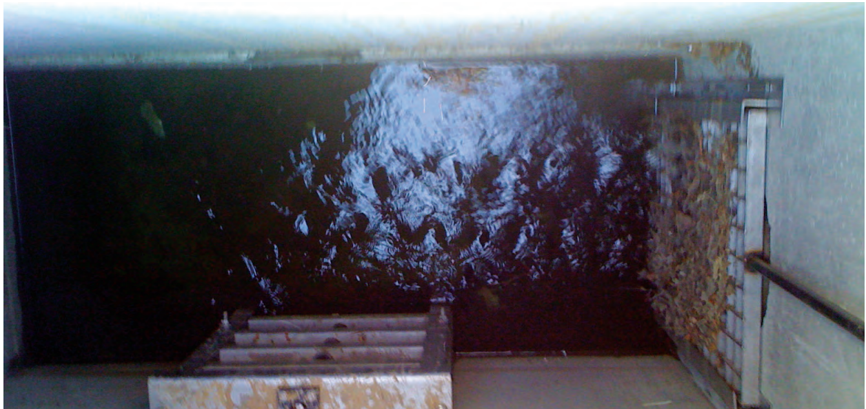
COMMUNE DE LÈGE-CAP FERRET - Place Reinhard - Décantation et dégrillage
