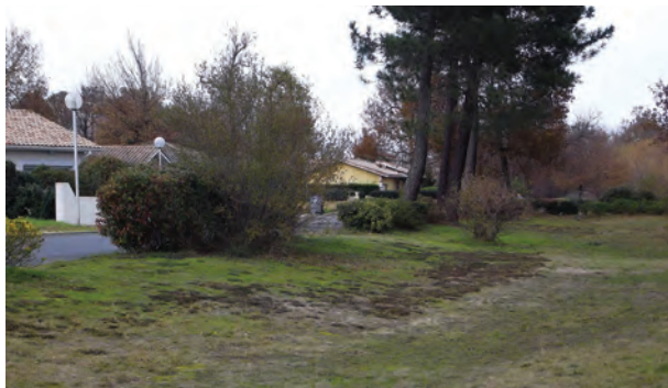
Noue en site « sable des Landes » avec présence de la nappe phréatique à faible profondeur.
