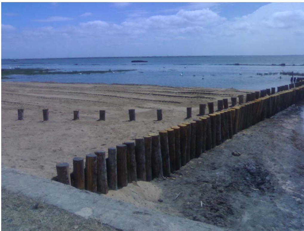
Ouvrage au droit de La Berle de Cassy à Lanton
