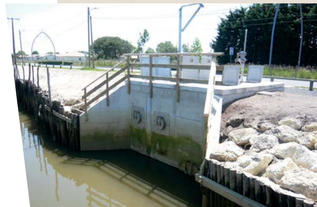
Après travaux : construction d'une station de pompage avec bassin de régulation
