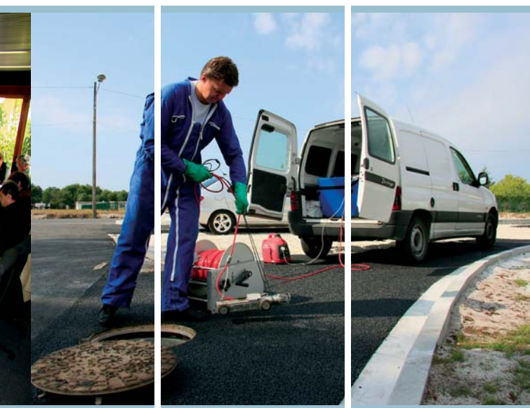
Contrôle du réseau d'assainissement
