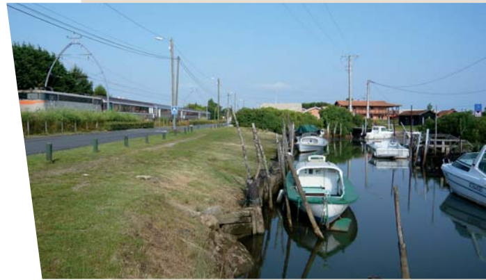
Avant travaux : lieu dit port de Meyran Est.
