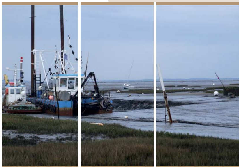
Travaux de dragage du chenal de Cassy à Lanton
