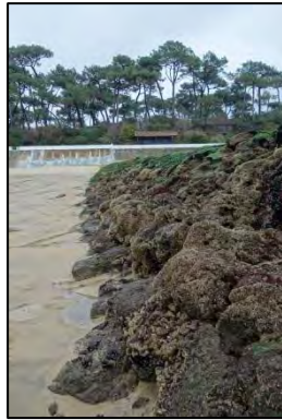
Figure 84. Vue depuis le bas de plage du versant nord de l'épi n°11
