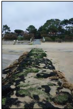
Figure 86. Vue générale du site n°12 depuis le bas de plage
