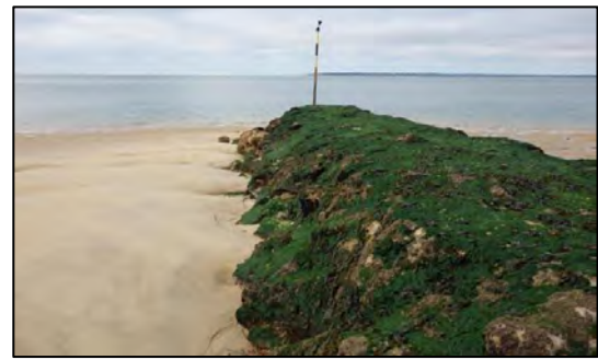
Figure 130. Versant sud de l'épi n°6
