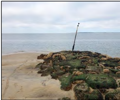
Figure 61. Versant sud de l'épi n°3
