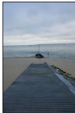
Figure 148. Vue générale de l'épi n°12 depuis le haut de plage
