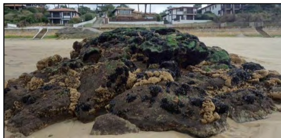
Figure 131. Partie terminale de l'épi avec présence de moules
