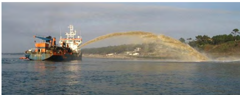
Figure 2. Rechargement du Pyla-sur-Mer par la méthode du rainbowing (SOGREAH 2006)
