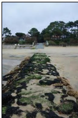
Figure 147. Vue générale du site n°12 depuis le bas de plage
