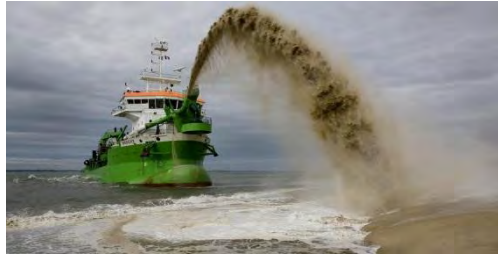
Figure 7. Rechargement de la plage du Pyla par rainbowing (campagne 2009)
