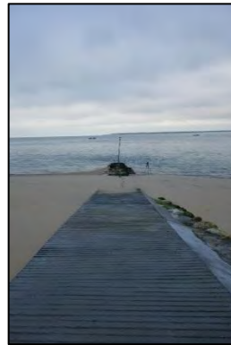
Figure 87. Vue générale de l'épi n°12 depuis le haut de plage
