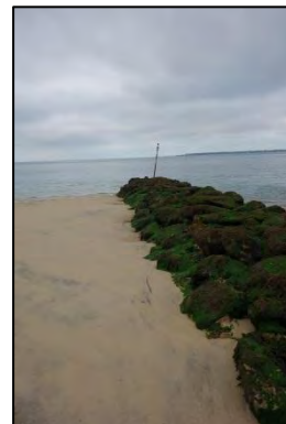
Figure 82. Versant sud de l'épi n°10
