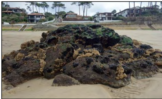
Figure 70. Partie terminale de l'épi avec présence de moules
