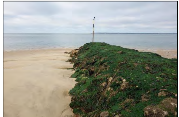
Figure 69. Versant sud de l'épi n°6
