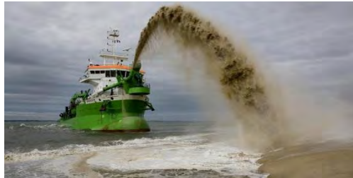
Figure 5. Rechargement de la plage du Pyla par rainbowing (campagne 2009)
