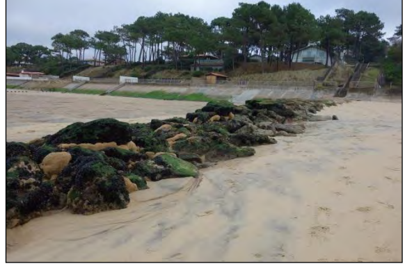
Figure 64. Versant sud de l'épi n°4
