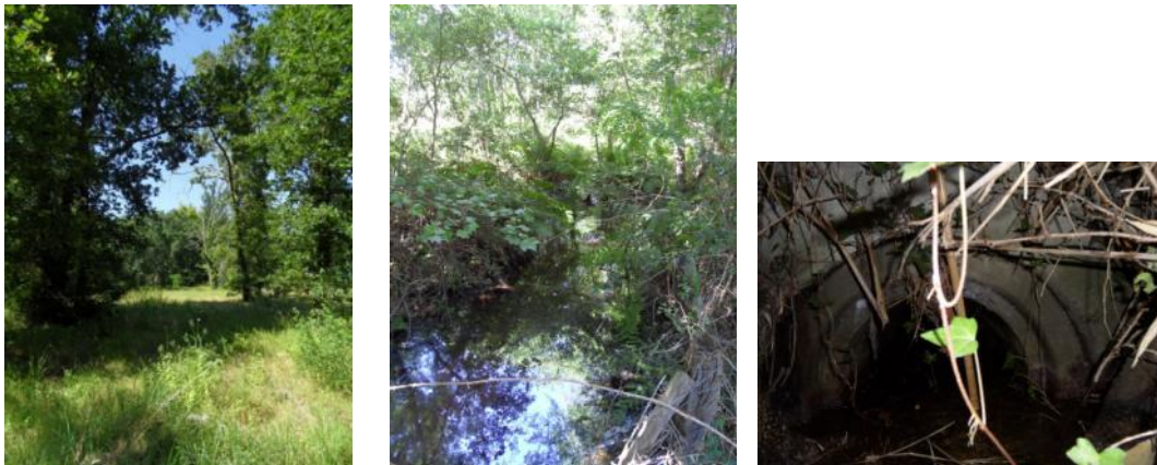
Zone remblayée chez particulier en aval de l'aérodrome (gauche), retour à ciel ouvert au niveau du village vacances (centre), avant d'être à nouveau busé (droite)
