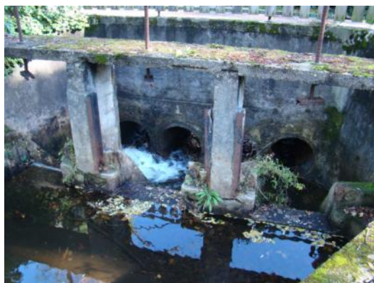
Illustrations du reste du vannage de l'ouvrage de déversement latéral aval OD2– Vue coté Canal des Landes (à gauche) et de l'ouvrage de déversement latéral aval OD2 - Sortie des busages coté contre canal (à droite).
