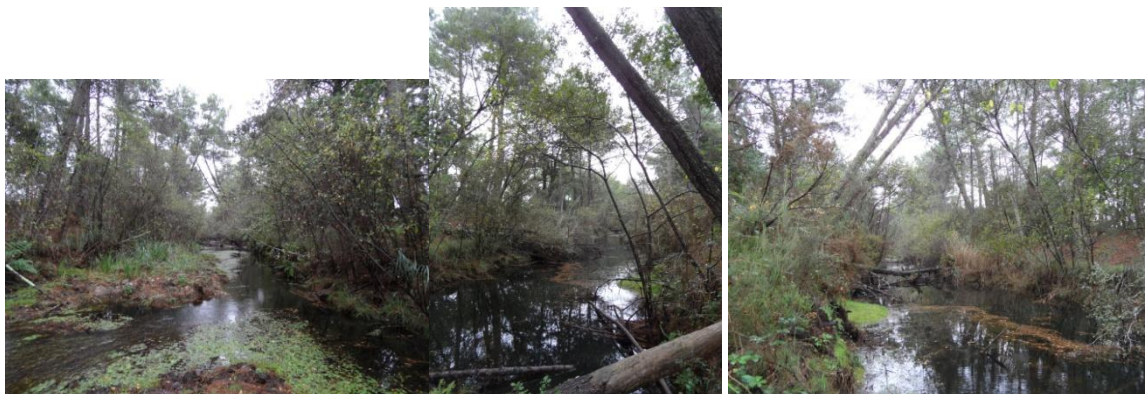
Illustrations du canal en aval de l'ouvrage de régulation : état de la ripisylve, méandrement du canal et formation d'îlots, berges à pentes douces.
