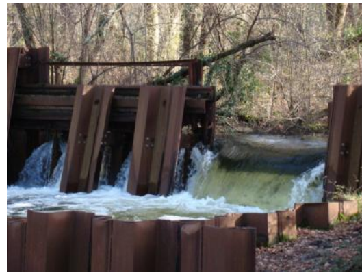
Illustrations de la déformation des structures de berges (février 2013 ; à gauche) et des perforations des structures en palplanches (février 2013 ; à droite).
