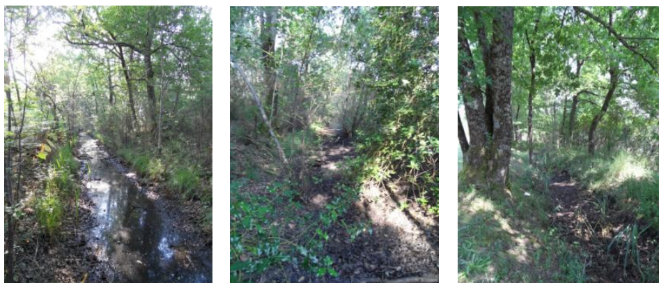
Le canal Delorme en assec au niveau du boisement de Villemarie (gauche et centre) ainsi qu'au niveau de l'entrée du Golf de Gujan (droite).
