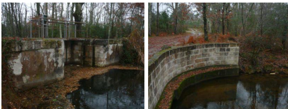
Illustration du vannage du contre-canal – Vue de l'amont (AQUACONSEIL – décembre 2012 ; à gauche) et du vannage du contre-canal – Vue aval (AQUACONSEIL – décembre 2012 ; à droite).
