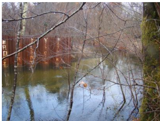
Illustrations du seuil SM06 contourné par la rive droite (février 2013 ; à gauche) et du seuil SM05 situé en amont de l'A660 (février 2013 ; à droite).
