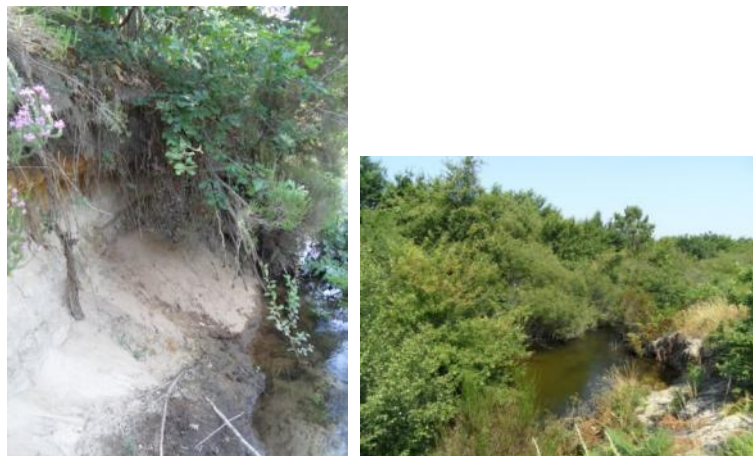
Illustrations des phénomènes d'érosion ponctuellement présents sur le linéaire
