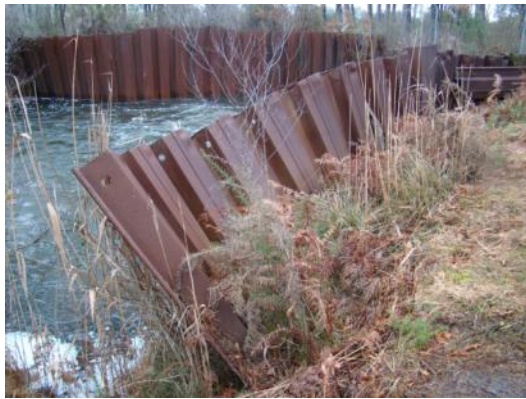
Illustrations de la déformation des structures de berges (février 2013 ; à gauche) et des perforations des structures en palplanches (février 2013 ; à droite).
