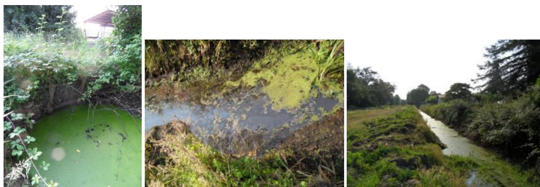
Zone stagnante du Canal Delorme avec développement de lentilles d'eau (gauche et centre) ; dépôt des matériaux de curage en rive gauche du canal (droite)
