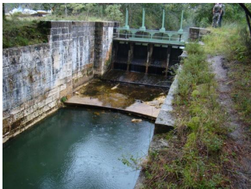
Vannes de l'écluse de la Teste fermées
