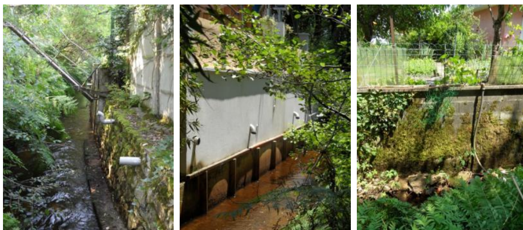
Exemple de zones de « rejets pluviaux » relevés sur le terrain (gauche et centre) et d'une zone de pompage (droite).
