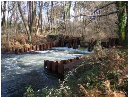
Illustration du seuil métallique type. Le rideau de palplanches aval se situe sous le niveau d'eau du bief aval.
