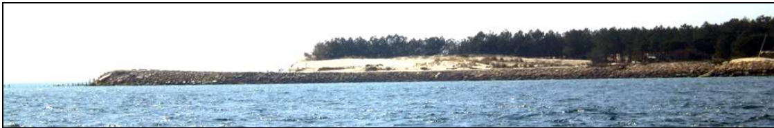
Document 32 : La Digue « Carpe Diem » construite par B. Barthertotte. Cliché Manciet Bruno.
